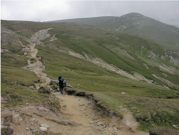
Fot. 5. Zniszczone podłoże ścieżki trawersującej wierzchołek Vf. Caraiman (2384 m n.p.m.)
