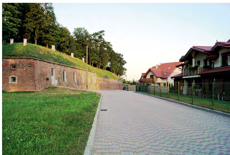
Ryc. 5. Fort Łysa Góra, którego otoczenie zostało zabudowane osiedlem domków jednorodzinnych
