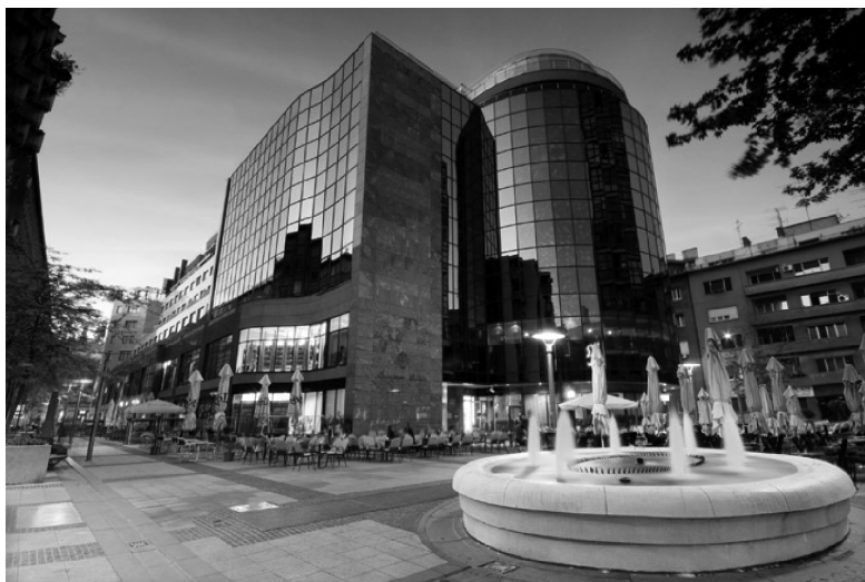
Slika 2. Importanne Galleria (Iblerov trg, Zagreb) (Izvor: http://www.importanne.hr )
