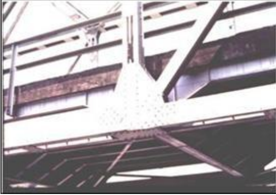
Fotografía No. 2: Vista de un nudo de cercha.
