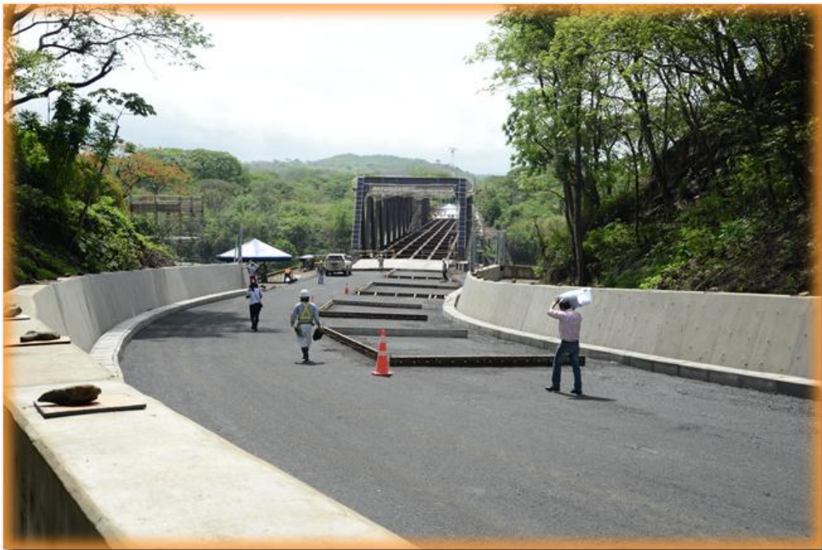
Imagen de Avance de la Subestructura en la Actualidad.
