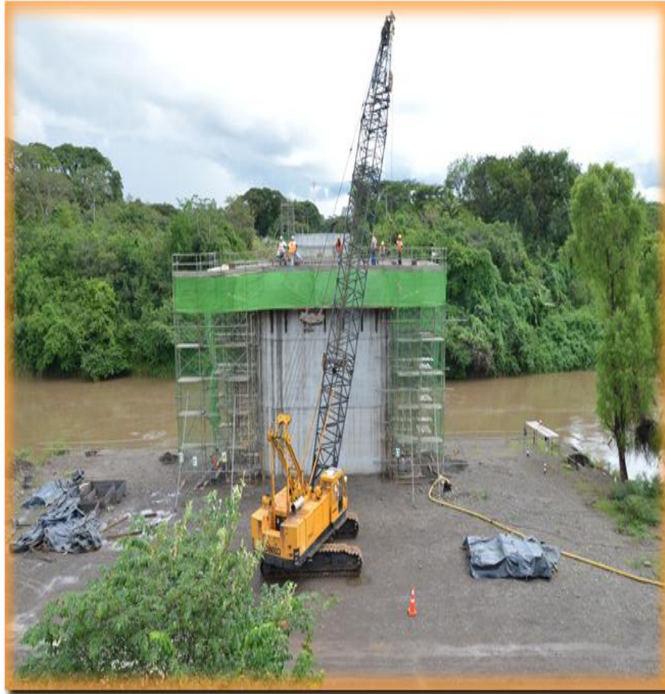
Construcción de un Estribo.
