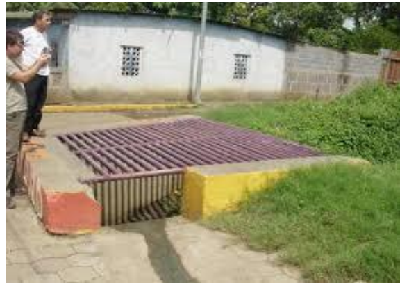
Imagen No. 58 Drenaje pluvial
