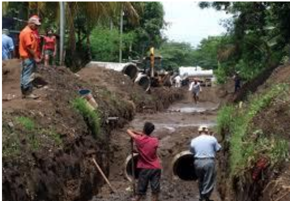
Imagen No. 57 Instalación de aguas grises
