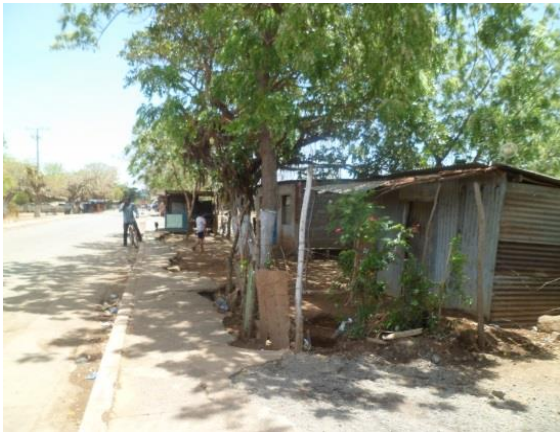
Imagen No. 53 vivienda en mal estado
