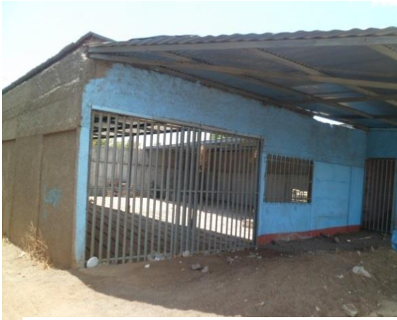
Imagen No. 51 vivienda en buen estado
