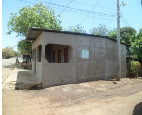
Imagen No. 52 vivienda en buen estado
