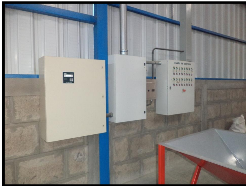
Fotografía # 6. Aseguramiento de Panel Eléctrico
