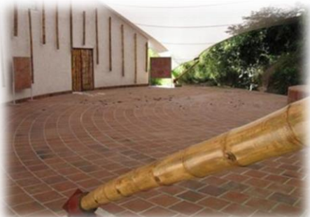
Imagen No. 19. Vista externa salón de conferencias. Fuente: http://tripadvisor.com.mx
