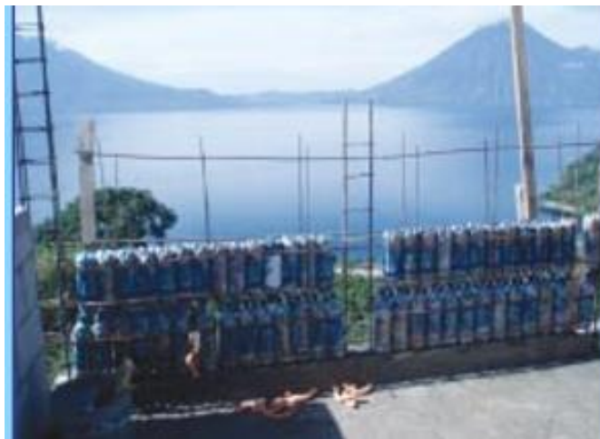
Imagen No. 84: Muro a base de botellas PET Fuente: Manual pura vida
