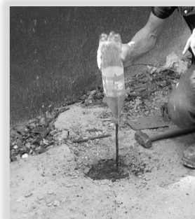
Imagen No. 93: Construcción de Columnas. Fuente: “Nuevas alternativas en la construcción: botellas PET con relleno de tierra.”
