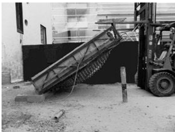
Imagen No. 95: Ensayo preliminar de volteo en muros de botellas. Fuente: “Nuevas alternativas en la construcción: botellas PET con relleno de tierra.”
