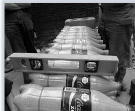
Imagen No. 91: Material de relleno de las botellas. Fuente: “Nuevas alternativas en la construcción: botellas PET con relleno de tierra.”
