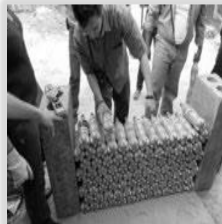
Imagen No. 92: Construcción de muro con botellas. Fuente: “Nuevas alternativas en la construcción: botellas PET con relleno de tierra.”
