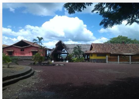
Imagen No. 33. : Parqueo. Fuente: Elaboración propia
