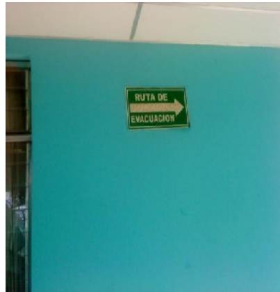
Señalización de Ruta de Evacuación.
