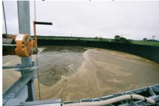
Figura 7. Uso de aguas cloacales para la producción de biogás
