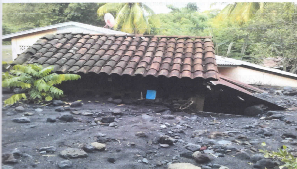
Imagen N° 5: Vivienda soterrada por el lahar ocurrido entre los días 8 y 9 del mes de octubre del año 2014 en la comunidad de La Unión, Isla de Ometepe.
