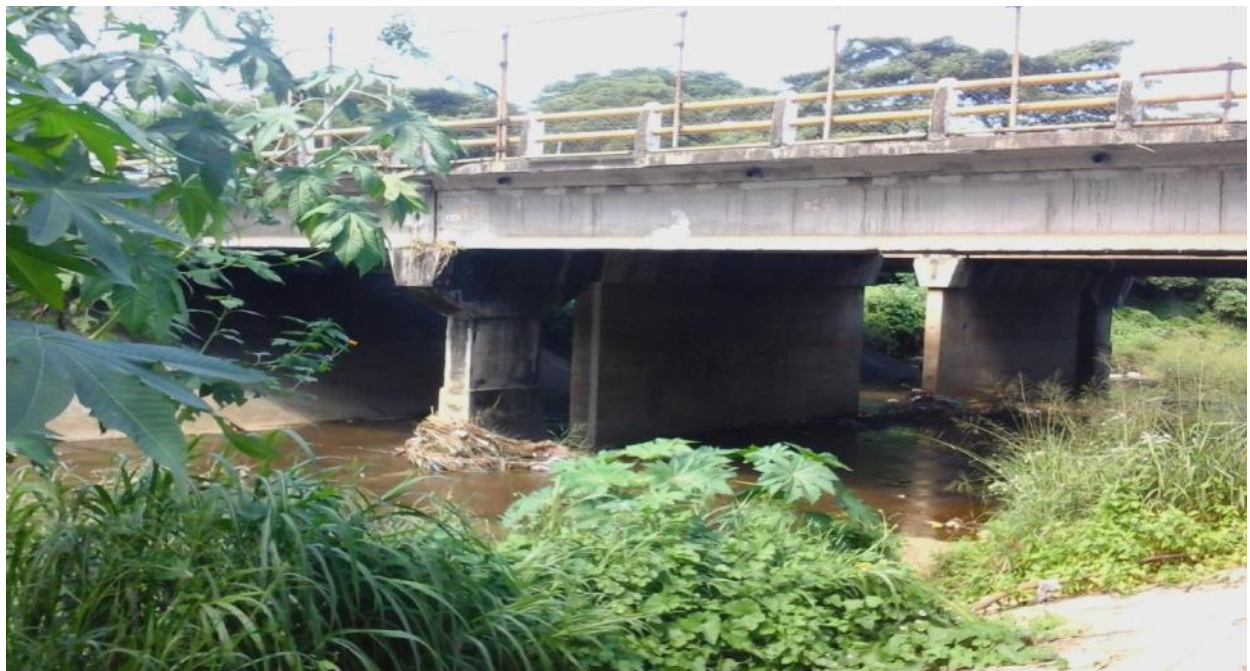
Figura 22: Fotos tomadas en el levantamiento topográfico del cauce natural en estudio. Fuente: elaboración propia, septiembre 2014.
