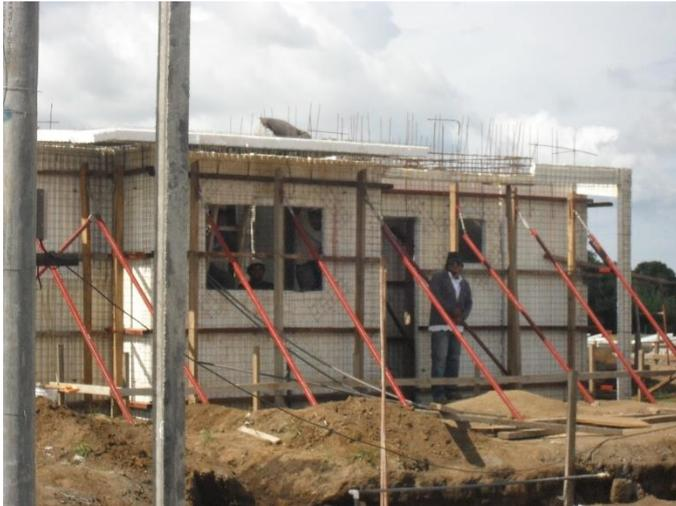
**Imagen 38.** Proceso de Instalación de los paneles
