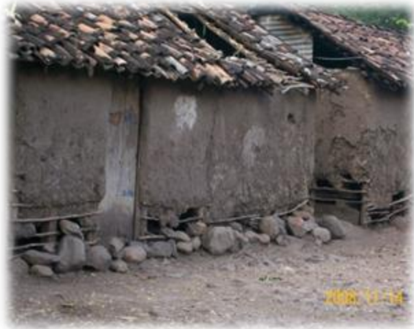
Piso de tierra
