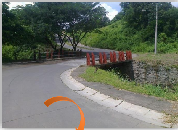
Vía principal de acceso de concreto hidráulico.
