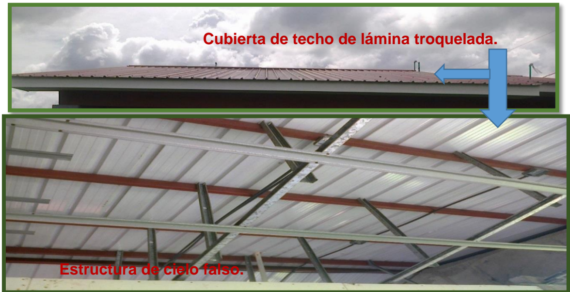
Ilustración 16. Cubierta de techo en Viviendas, Fuente: Propia
