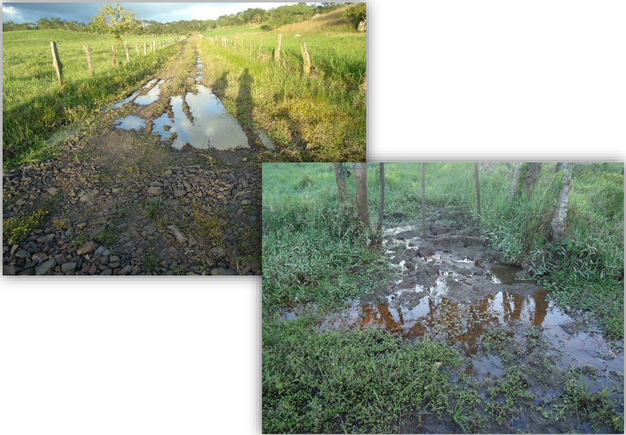
Ilustración 49. Amenazas: emposamiento de aguas, dentro del terreno.
