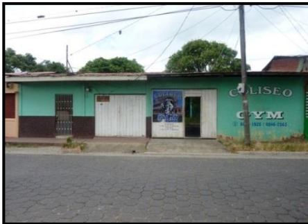
Foto N° 17. Fachada principal Fuente: Tomada por grupo
