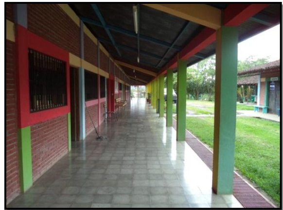
Foto N° 4. Pasillo, Los pipitos Estelí Fuente: Equipo de trabajo
