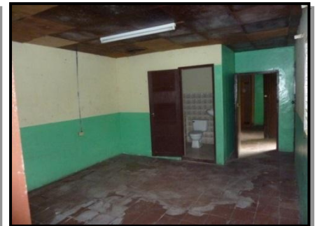
Foto N° 19. Vista interna Fuente: Tomada por grupo
