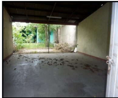
Foto N° 18. Vista interna Fuente: Tomada por grupo
