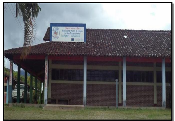
Foto N°6. Vista de materiales en fachada Fuente: Equipo de trabajo
