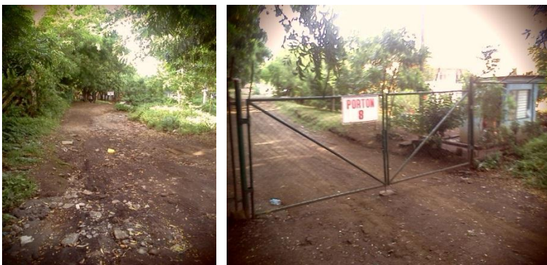
Imagen 35 Acceso No. 8. Fuente: Elaboración propia
