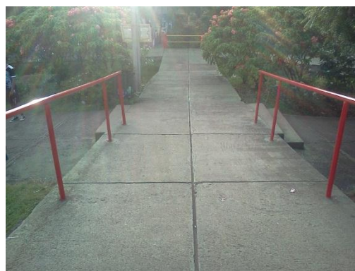
Imagen 22 Rampa de Acceso a Puente del RURD // Fuente: Propia
