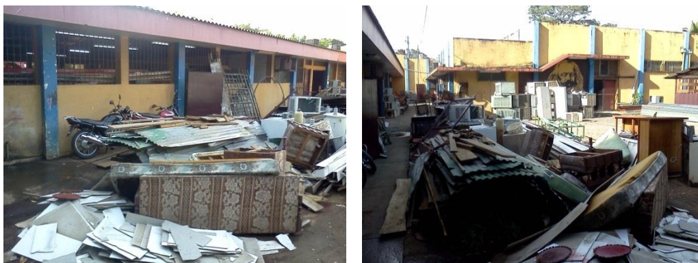
Imagen 33 Área de mantenimiento general de la Universidad. // Fuente: Propia
