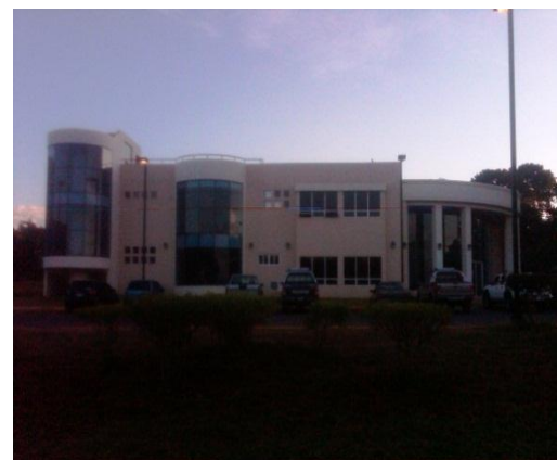
Imagen 60 Imagen Arquitectónica de la UNAN-Managua; CIGEO // Fuente: Propia
