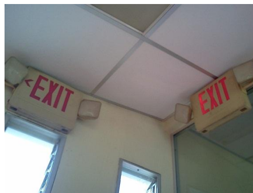
Imagen 29 Luces de emergencia en el Pabellón 11 // Fuente: Propia
