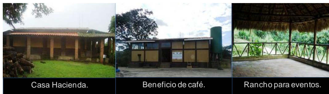
Imagen No. 8 Edificaciones de Finca Las Delicias.
