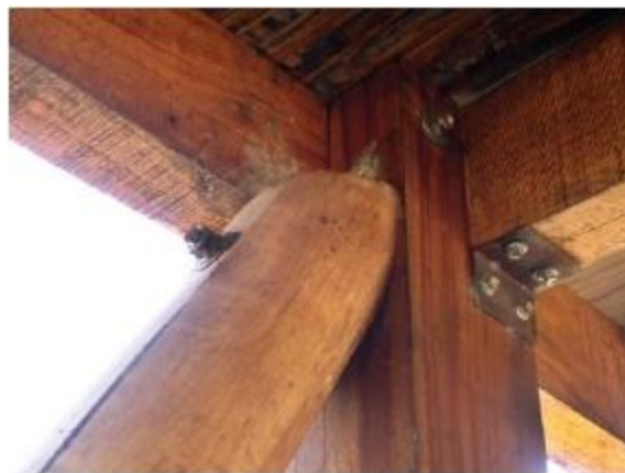
Ilustración N° 7. Unión de piezas con pernos (B).
