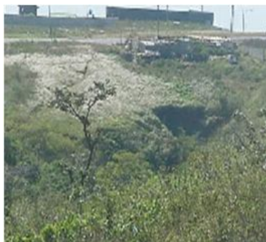
Ilustración N° 23. Deslizamiento en el sector del barrio Carlos Moya.
