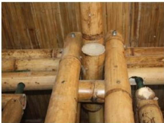
Ilustración N° 6. Unión de piezas con pernos (A).
