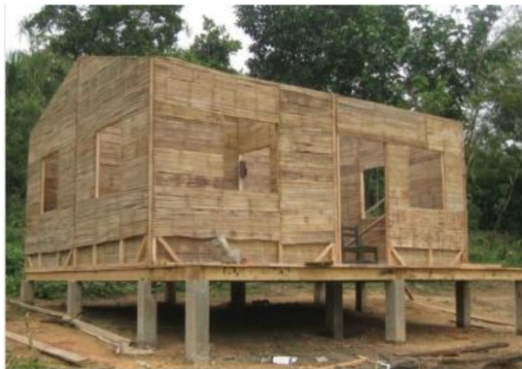
Ilustración N° 5. Construcción de una vivienda típica de bambú.
