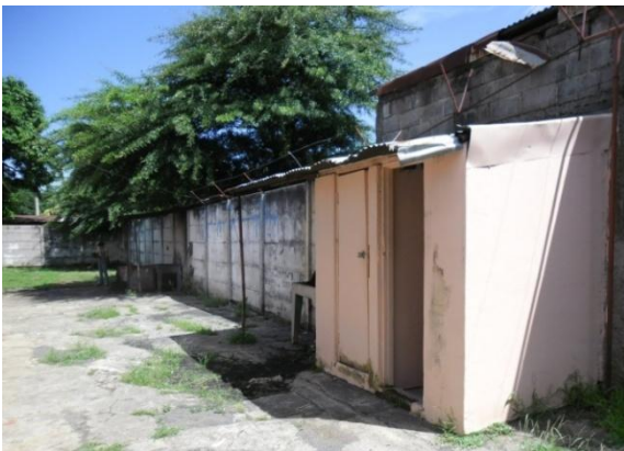
Foto No. 5 Área servicio en el costado este.
