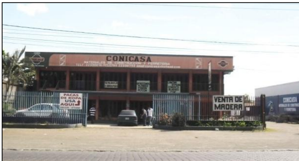
Foto No. 28 Construcciones predominantes en el sitio y su entorno inmediato.
