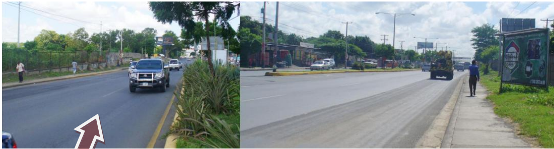
Foto No. 25 Carretera Panamericana Norte km 9.
