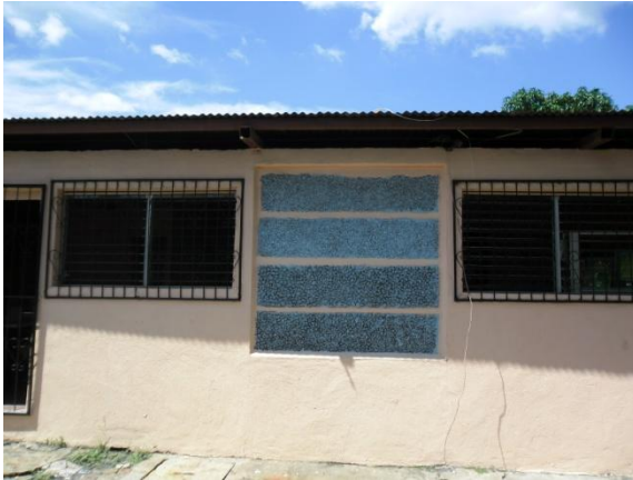
Foto No. 8 Detalle de Fachada Este.
