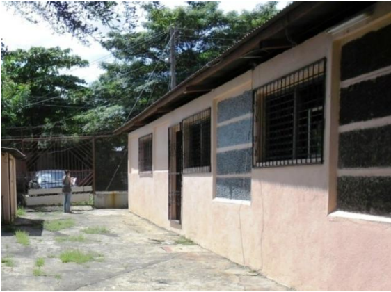
Foto No. 3 Fachada Este de la biblioteca Ajax Delgado.
