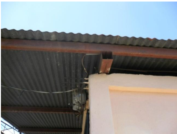
Foto No. 9 Detalle de estructura de techo.
