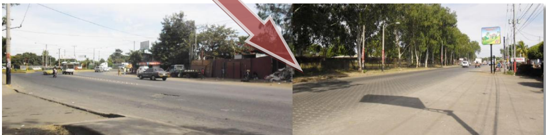
Foto No. 27 Pista Rural de Circunvalación o Pista del Mercado Mayoreo.
