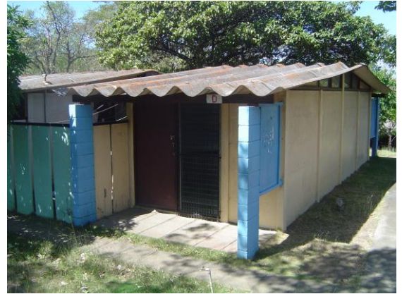
Foto N° 13 Vista panorámica de las Residencias Universitarias “Arlen Siu” de la UNAN-Managua.
