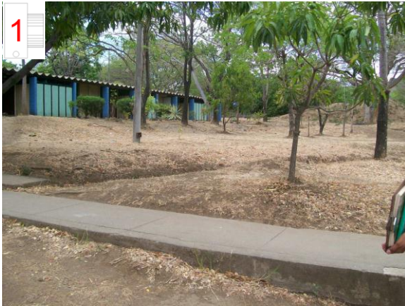
Foto N° 27 Vista 1 de la Alternativa N°3.
