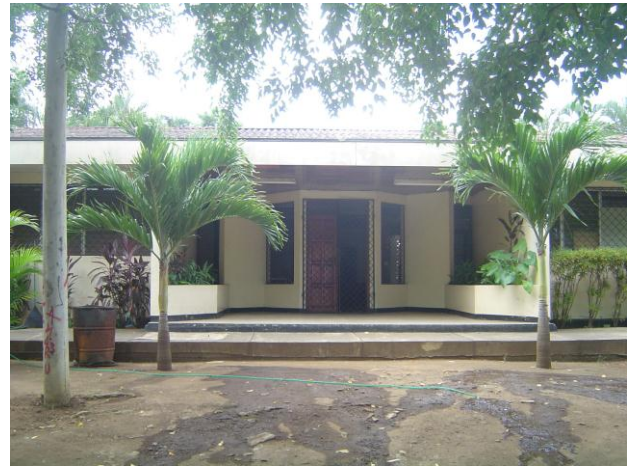
Foto N° 3 Fachada principal de la Residencia Universitaria de la UNI.
