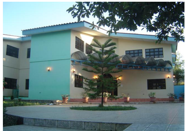
Foto N° 1 Fachada principal del edificio de Residencias Universitarias “Arlen Siu” de la UNAN-Managua.
