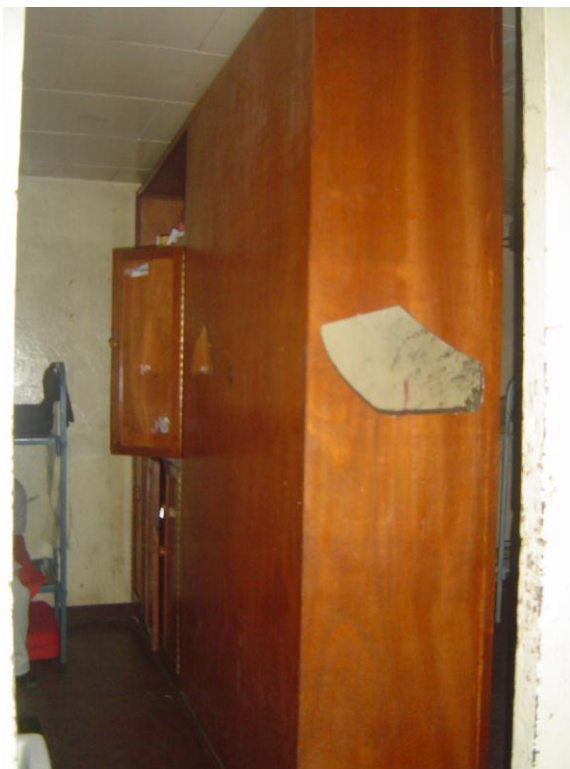
Foto N° 10 Armario de la Residencia Universitaria de varones de la UNAN-Managua.
