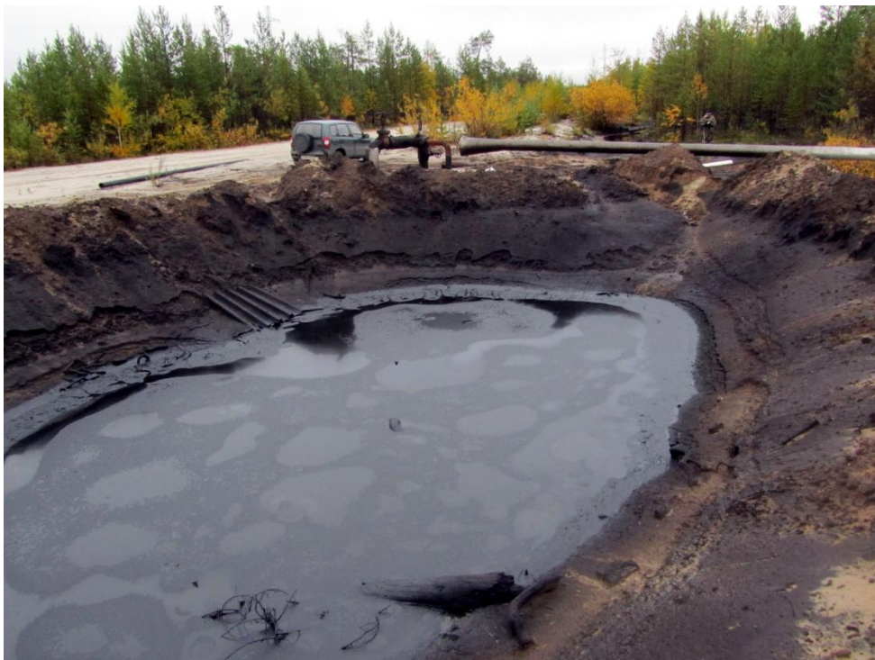
Рисунок 4 – Приямок для сбора нефти [54]
