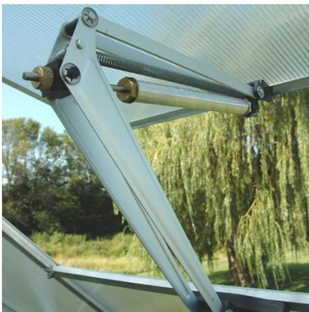
Рисунок 8. - Автоматический проветриватель Автовент XL
