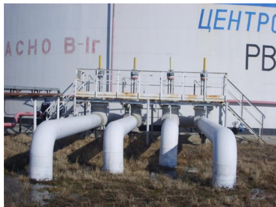
Рис. 5. Приемо- раздаточные устройства с коренными задвижками.
