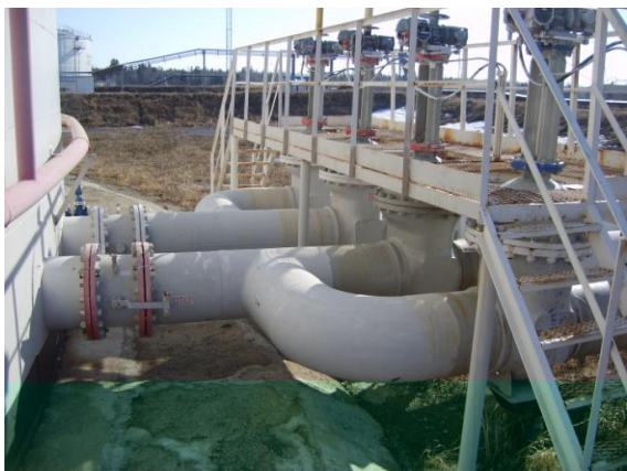
Рис. 5. Приемо- раздаточные устройства с коренными задвижками.
