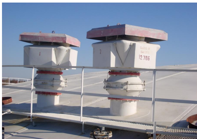
Рис. 3. Дыхательные клапаны КДС с огневыми предохранителями.
