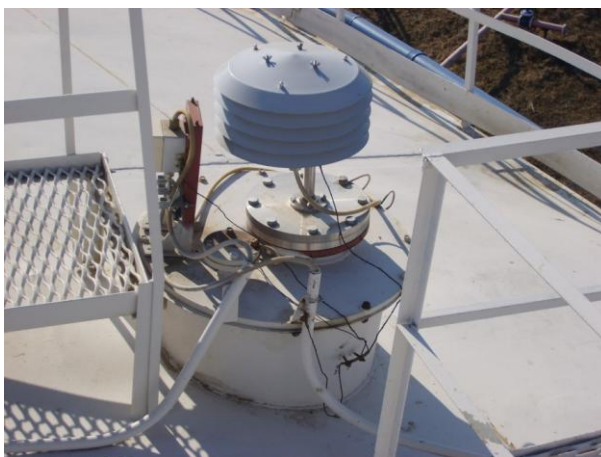
Рис. 9. Радарный уровнемер системы KOR-VOL NT.
