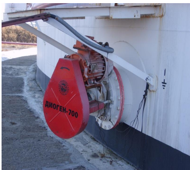
Рис. 7. Устройство для размыва донных отложений «Диоген-700».
