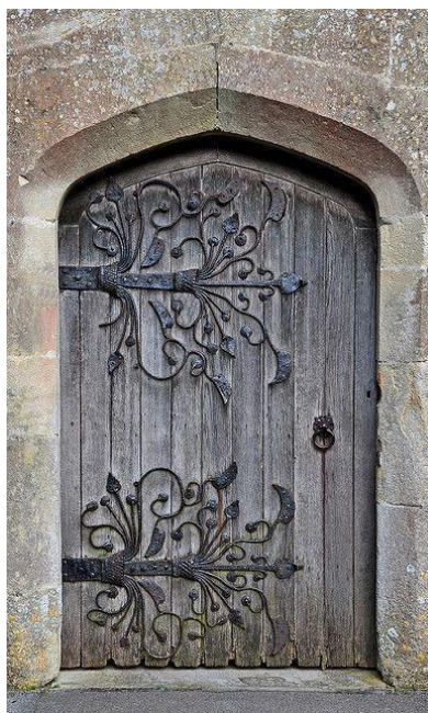
Рисунок 2. Дверь с металлическими накладками.
