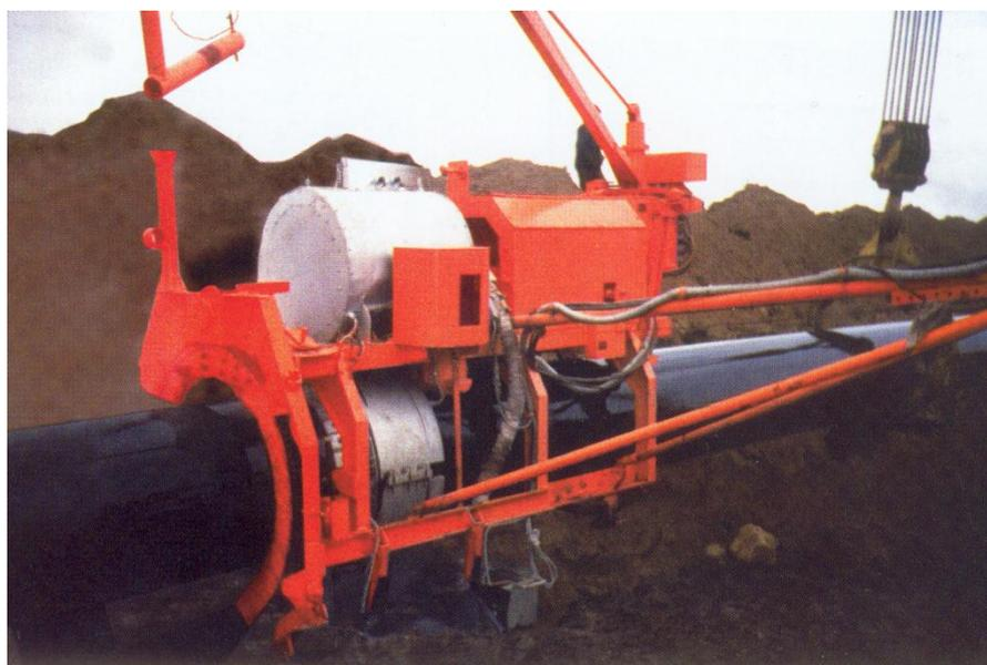
Рисунок 2 – Изоляционная машина типа МИАБ
