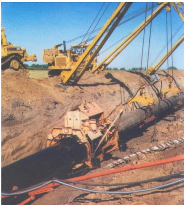
Рисунок 1 – Машина грунтовочная типа МГ
