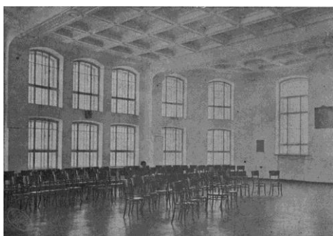
Рис. 3. Первоначальный вид помещения лекционной аудитории. 1912 г.
