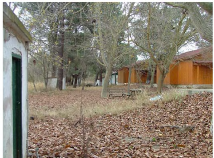
Εικ.2 Υφιστάμενες κατασκευές και φύτευση του χώρου υποδοχής.
