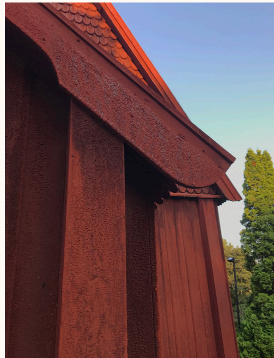
Kuvat 16 ja 17: Paanukatto Sottungan puukirkossa, kirkko on siirretty kunnostettu paikalleen vuonna 1802.
