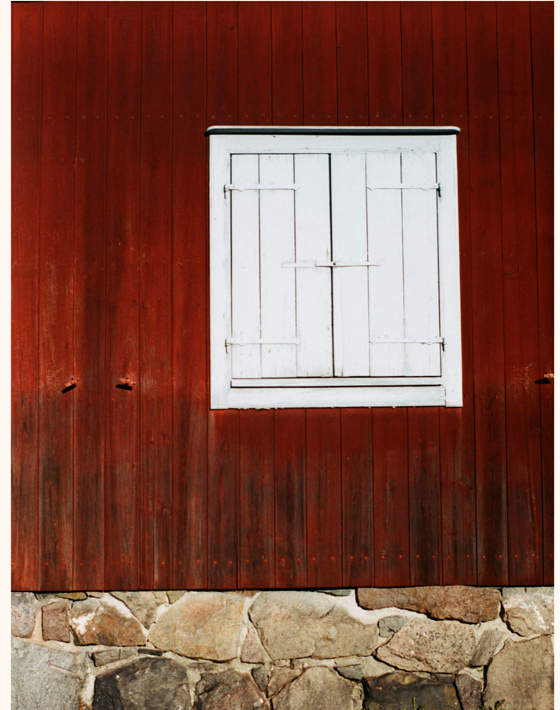
Kuva 19: Ikkunahuukut suljettuna Qwenselin talossa
