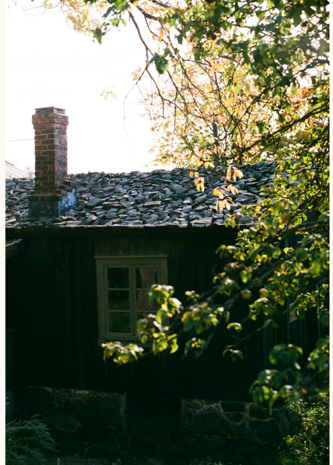
Kuva 18: Tuohikate pysyy paikallaan sen päälle asetettujen kivien ansiosta.
