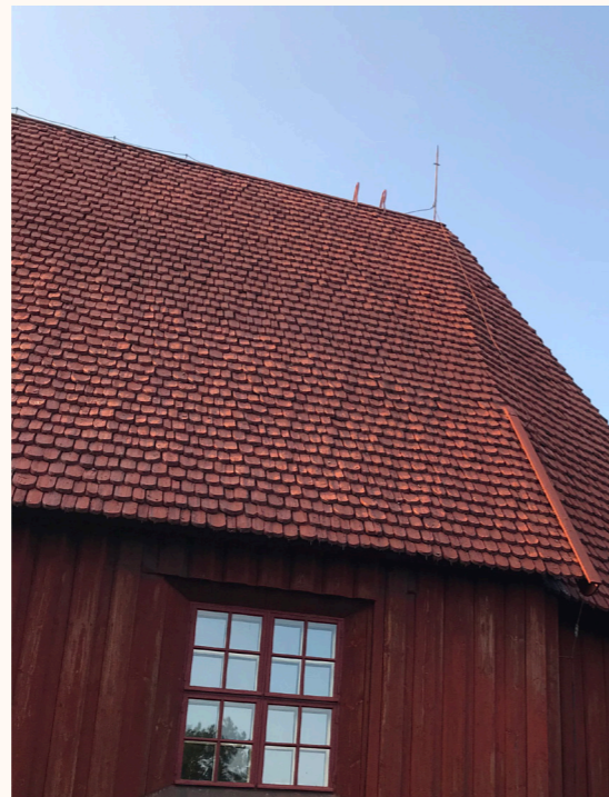
Kuvat 16 ja 17: Paanukatto Sottungan puukirkossa, kirkko on siirretty kunnostettu paikalleen vuonna 1802.
