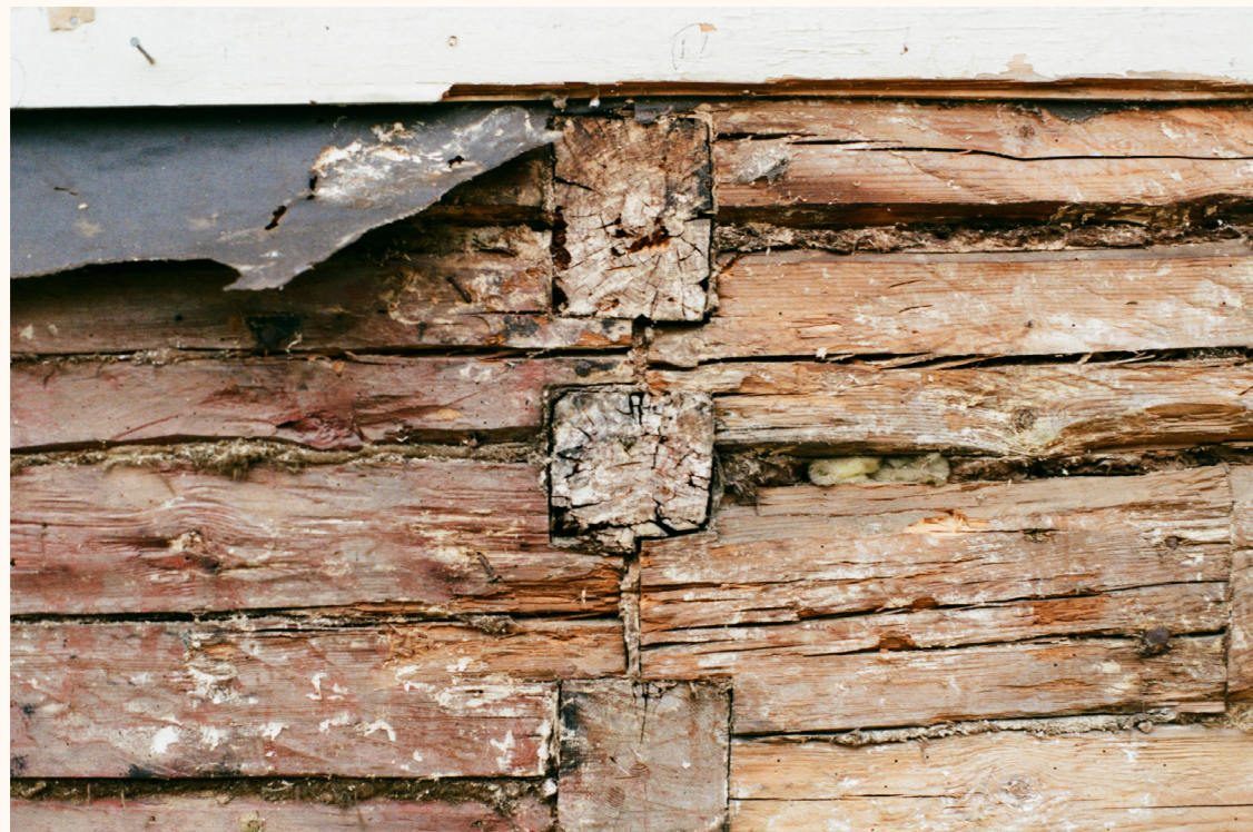
Kuva 12: Vanhan talon korjaustyömaa Urössä.
