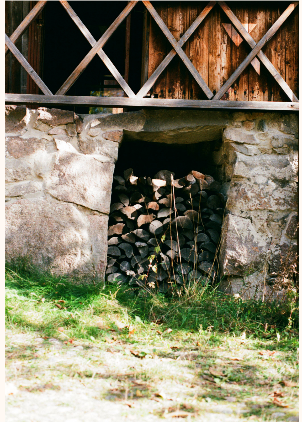
Kuva 13: Halkosuoja vanhan talon kivijalassa
