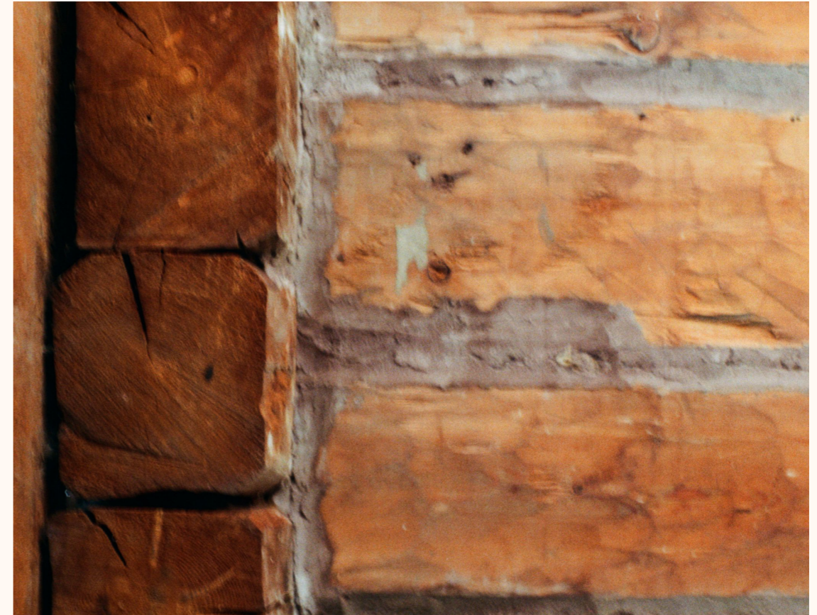
Kuva 14: Hirren välit on tilkitty savimakkaroidilla
