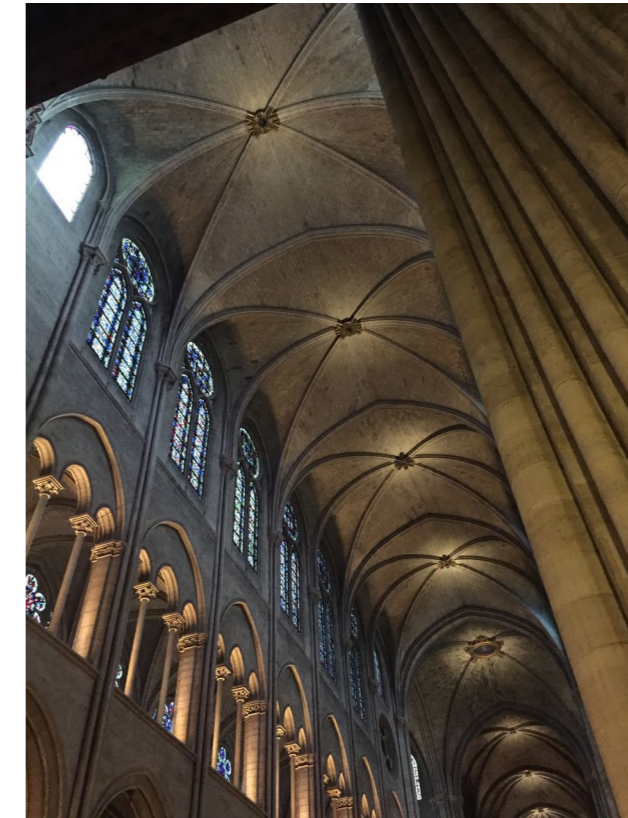
Kuva 84. Pariisin Notre-Damen katedraalissa näkyy gotiikalle ominaiset ruodeholvit. Vanhan tyylin rehabilitointia toivotaan mahdolliseksi kehittyvän teknologian ja rakennustekniikan myötä.
