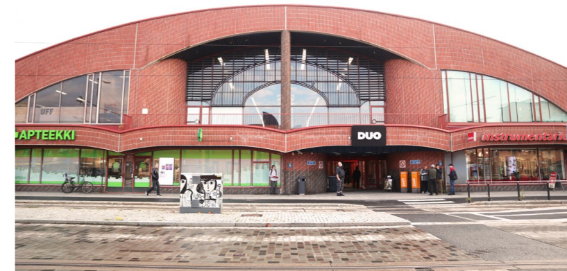
Kuva 151. Pietilöiden suunnitteleman Hervannan kauppakeskus Duon vanha osa valmistui 1970-luvun lopulla. Julkisivussa on nähtävissä viitteitä Tampereen keskustan kauppa-halliin muun muassa kaariaiheiden osalta.
