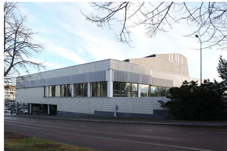
Kuva 110 (ylhällä). Alvar Aallon suunnitelma Finlandia-talo otettiin käyttöön vuonna 1971.
