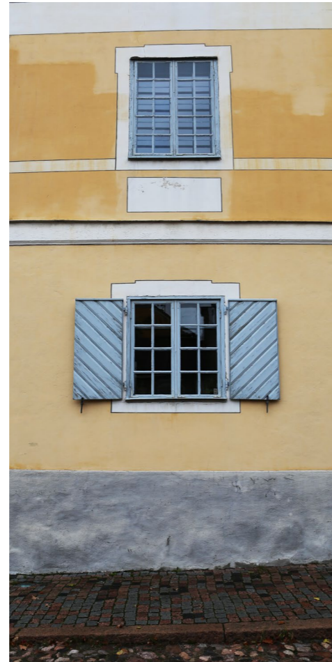
Kuva 93. Porvoon nykyisen tuomiokapitulin rakennukseen on maalattu kivirakennuksille tyypillisiä profiileja.
