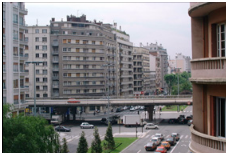
Photographie 1 - Vue de l'autopont depuis le nord ouest de la zone d'étude - cours J. Jaurès - J. Jouannet - juin 2000.
