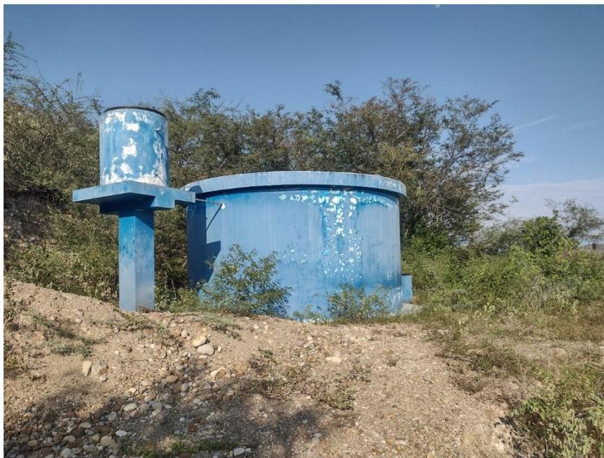
Nota. Reservorio de concreto armado mantiene un vol. aproximado de 20 m<sup>3</sup>, y un tanque elevado clorador de aprox. 1100 lt, en condiciones óptimas de uso, el propósito es otorgarle un correcto almacenamiento de agua para consumo de la población del caserío de Pushura Baja – Bellavista.
