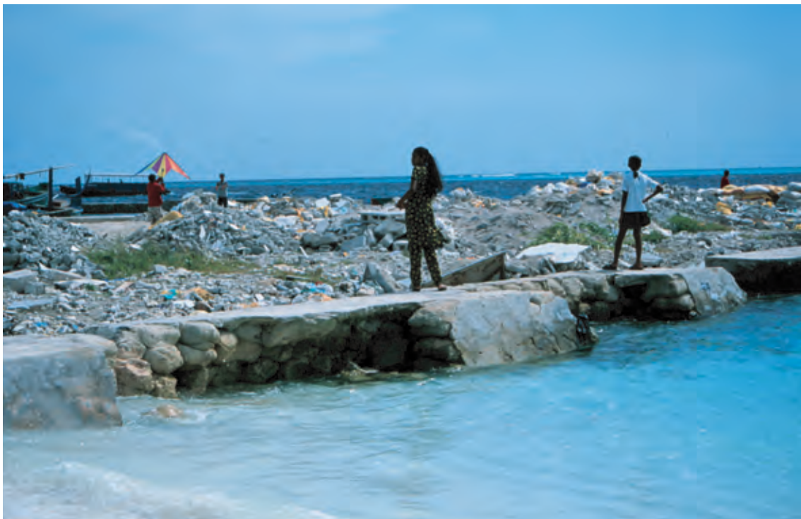
Île de Vilingili, quai nord-nord-ouest en 2001
