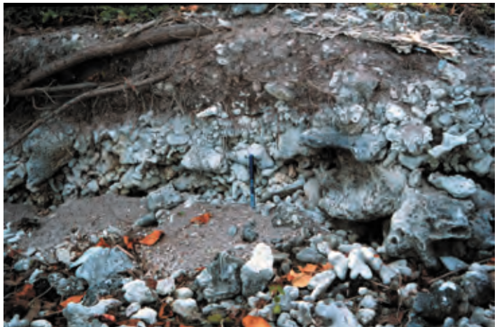
Les anciens dépôts sont en voie de démantèlement
