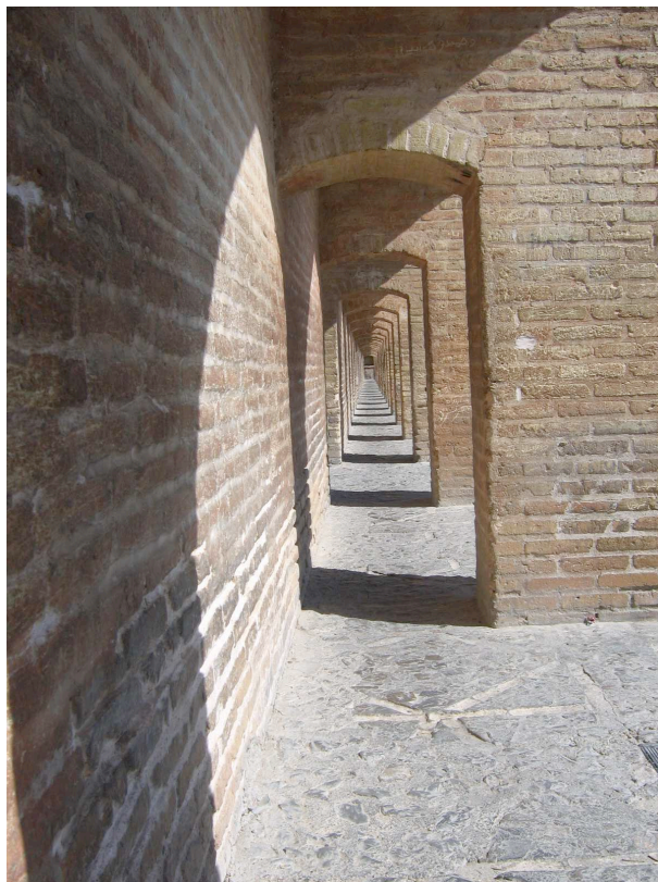
Fig. 1.10. Illustration du point de fuite central. Si-o-se Pol ou 33 Pol (le pont aux 33 arches), Isfahan, Iran.
