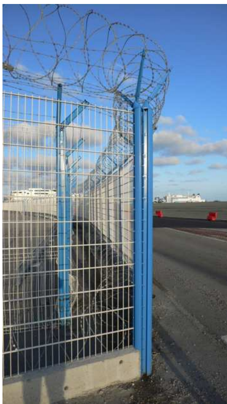
Fig. 2.4.4. ; La double clôture sur le parking nord du port transmanche à Cherbourg. Les migrants ne peuvent plus entrer en escaladant les grilles, ils passent maintenant par le portail d'entrée... OT, 24.03.09
