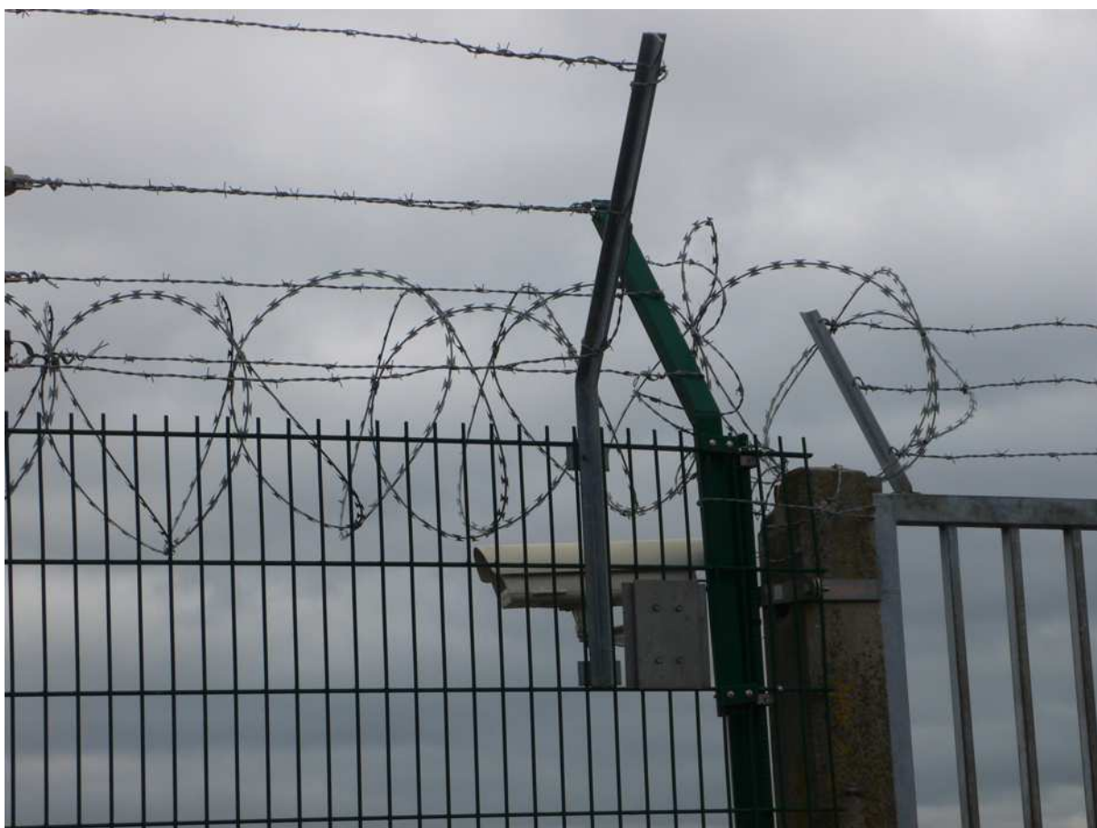
Photo n°10 - Barrière, grille, concertinas, bavolets et caméra de vidéo-surveillance autour de la gare maritime de Ouistreham : un dispositif classique de contrôle et de surveillance dans les ports transmanche aujourd'hui. [OT, 30/04/2008]
