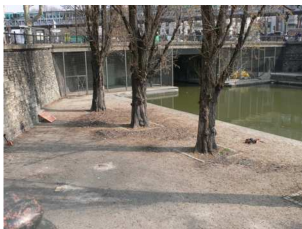
Photo n°22 - A proximité de la station de métro Jaurès (ligne 5), la ville de Paris a également redessiné l'espace urbain en fermant en 2010 l'accès au dessous du pont pour empêcher les migrants «clandestins» de s'y installer pour dormir. [OT, 16/03/2011]
