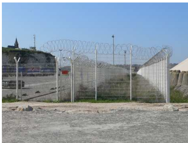
Fig. 2.4.3 ; Port de Dieppe. La clôture autour du parking poids lourds a été doublée. Un fossé déjà existant a été utilisé pour créer un obstacle supplémentaire. Des barbelés rasoirs y ont été installés. OT, 20.04.11
