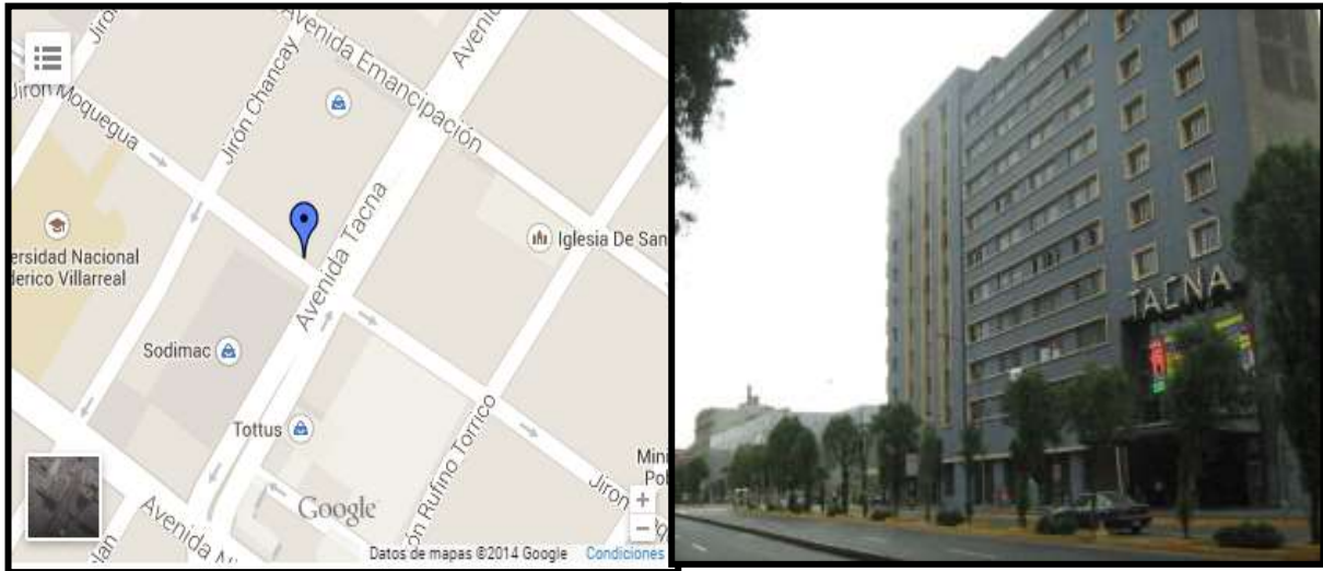
Figura 26. Ubicación Edificio y Cine Tacna. Foto e imagen: Google 2016
