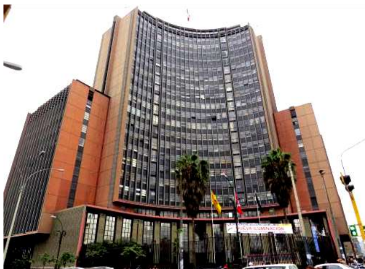
Figura 10. Edificio Alzamora Valdez. (Fotografía: Vanessa Patiño)
