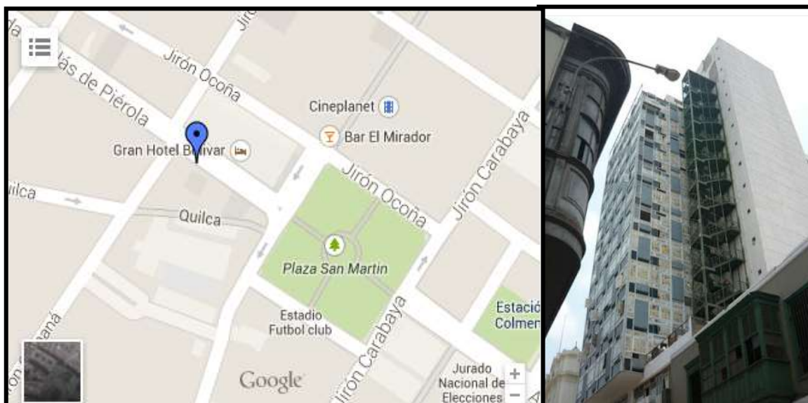
Figura 24. Ubicación Edificio de Seguros el Sol. Foto e imagen: Google 2016
