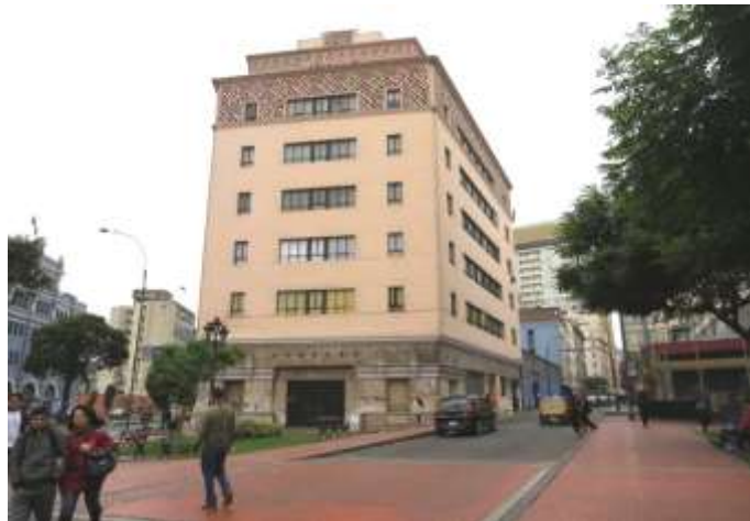
Figura 7. Edificio Wilson. (Fotografía: Vanessa Patiño)
