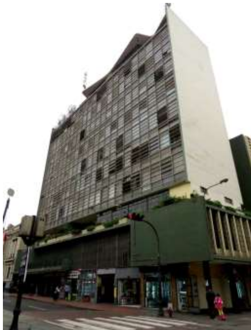
Figura 14. Edificio de Seguros Atlas. Fotografía: Vanessa Patiño
