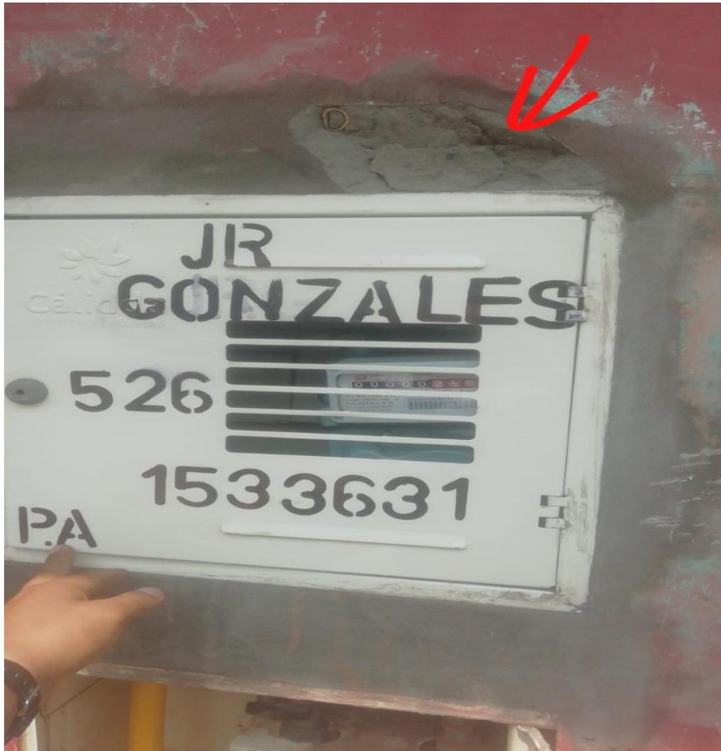
Figura 5: Mal resane de Tubería que llega a Gabinete.
