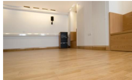
Figura 117: Aplicación de piso Harlequin flexible en Sala de ensayo. Fuente: Recuperado de https://bit.ly/2R2W9mX
