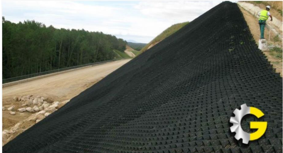
Figura N° 9: Refuerzo de talud con Geoceldas
