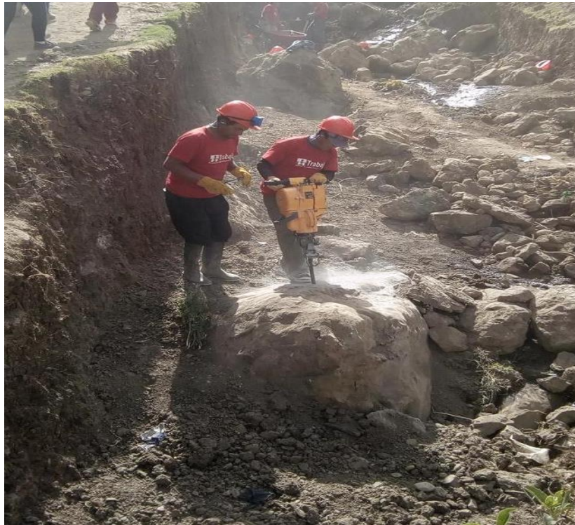
Figura N°52: Perforación de roca para voladura
