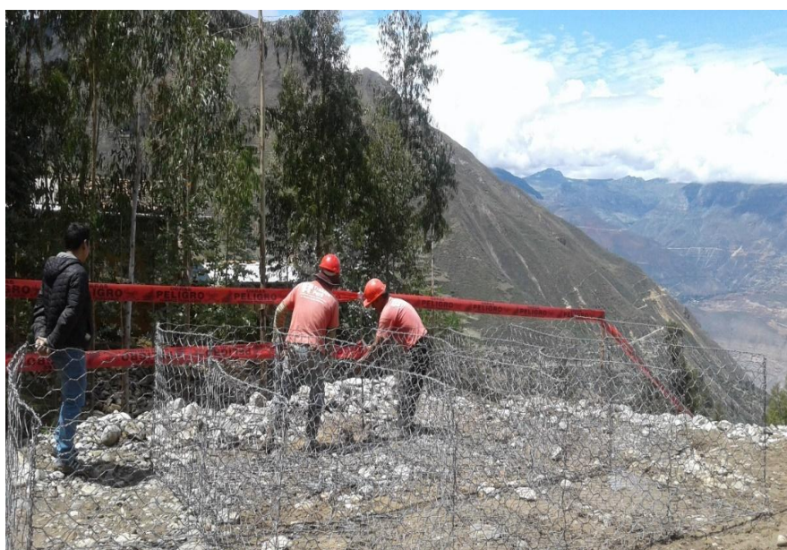
Figura N° 59: Armado de los gaviones
