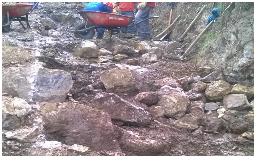
Figura N° 51: Corte de terreno semirrocoso manual
