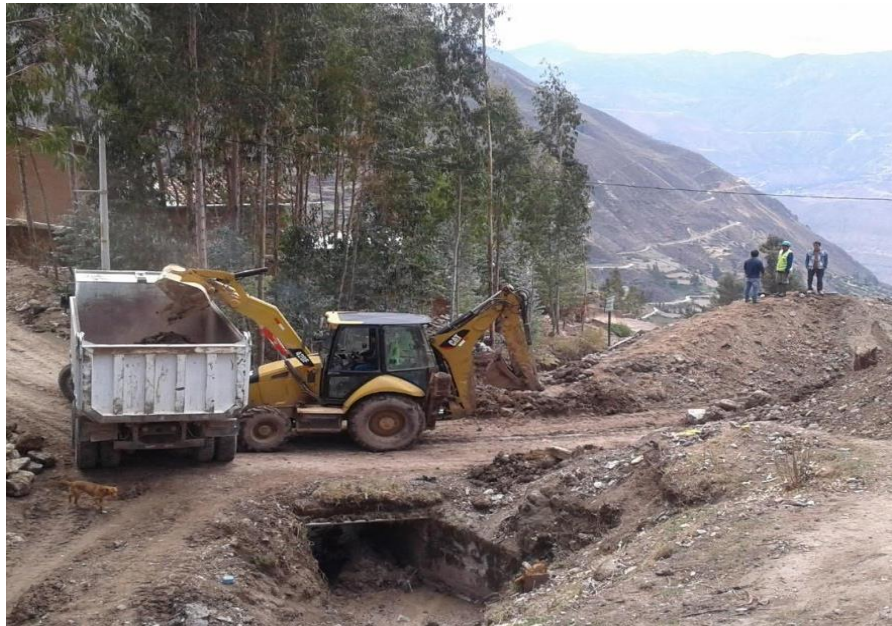
Figura N° 55: Eliminación de material excedente con maquinaria
