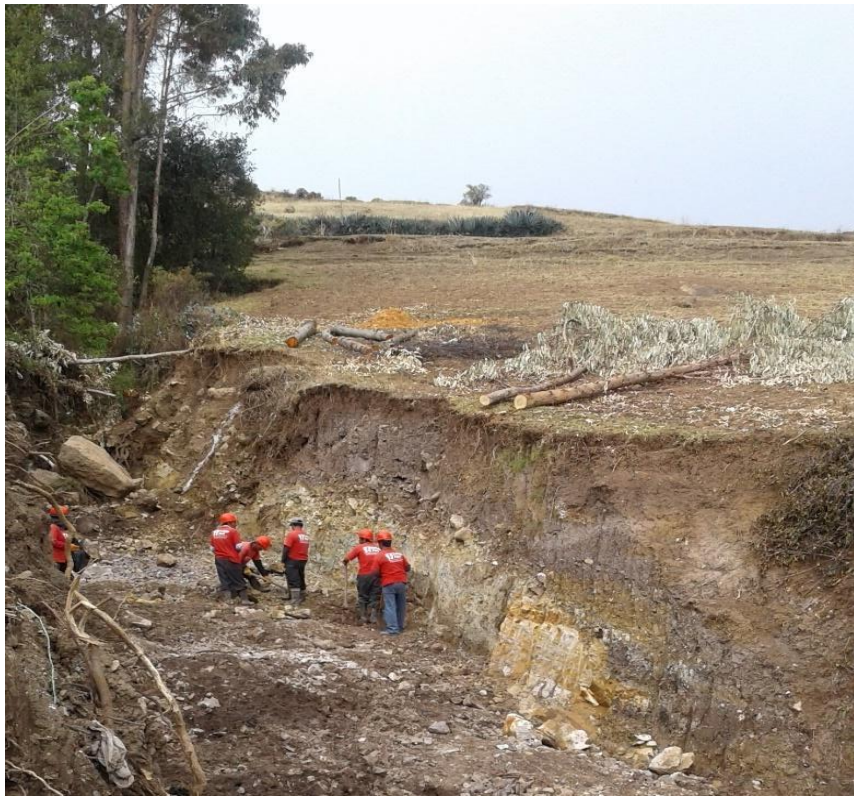
Figura N° 53: Excavación de plataforma y pared manual
