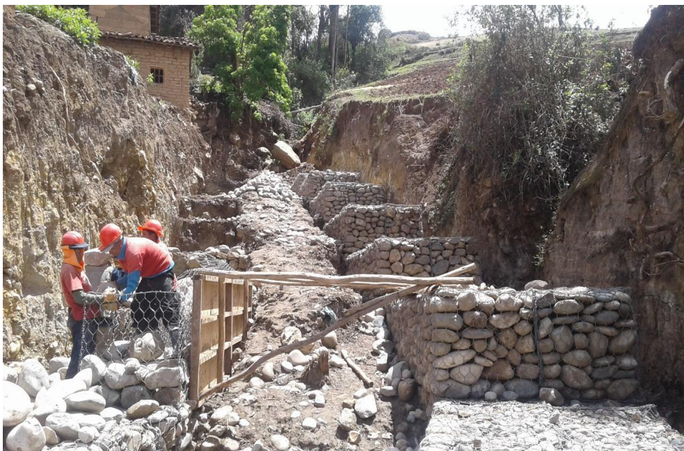
Figura N° 61: Llenado de los gaviones
