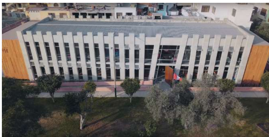
IMAGEN 41: VISTA AEREA - PLAZA BIBLIOTECA SUR FUENTE: CEREBRIO NETWORK WEBSITE
