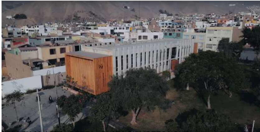
IMAGEN 39: VISTA AEREA - PLAZA BIBLIOTECA SUR FUENTE: CEREBRIO NETWORK WEBSITE
