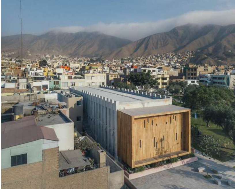
IMAGEN 15: LA PLAZA – BIBLIOTECA SUR FUENTE: RAMIRO DEL CARPIO FOTOGRAFÍA
