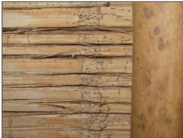
Figura 104 : Daño causado por escarabajos en el bambú, Colombia
