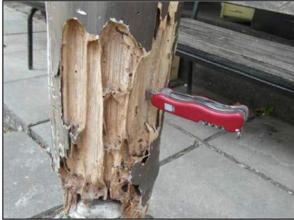
Figura 103 : Daño severo causado por termitas en el bambú, Costa Rica
