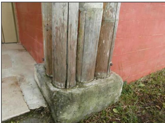
Figura 105 : Daño por hongos causante de fisuras y blanqueamiento del bambú, Colombia
