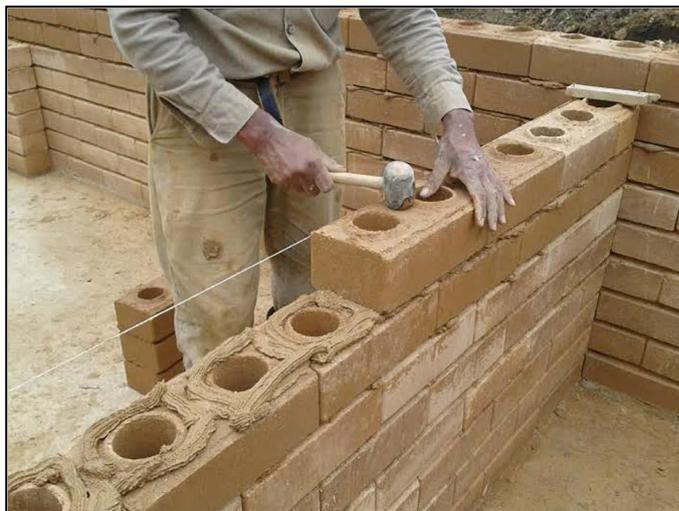
Figura 35 : Aspectos del proceso constructivo con BSC
