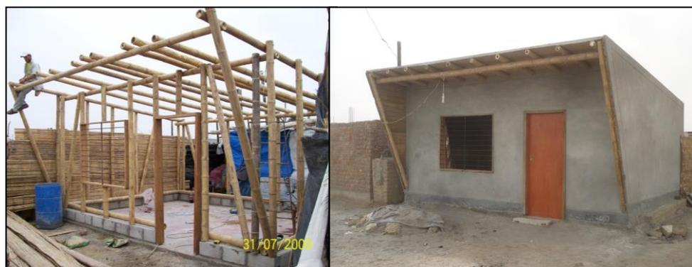
Figura 91 : Proyecto Modulo de vivienda, San Clemente Pisco, costo aproximado S/ 8,000.00 (24.6m<sup>2</sup>), Perú
