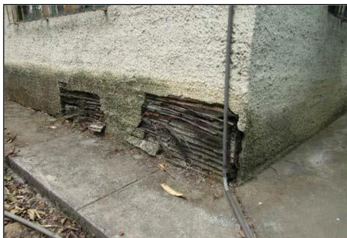
Figura 106 : Pudrición de paredes de bambú y presencia de moho en la base debido a salpicado de agua de lluvia proveniente del techo, Costa Rica
