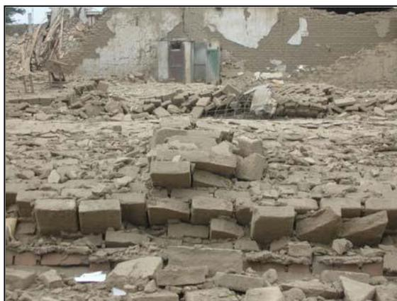
Figura 9 : Muestra de la baja adherencia en construcciones de adobe posteriores al Terremoto de Pisco 2007.
