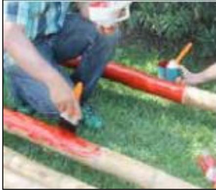
Figura 101 : Colocación de pintura al óleo a la caña guadua ubicada en exteriores
