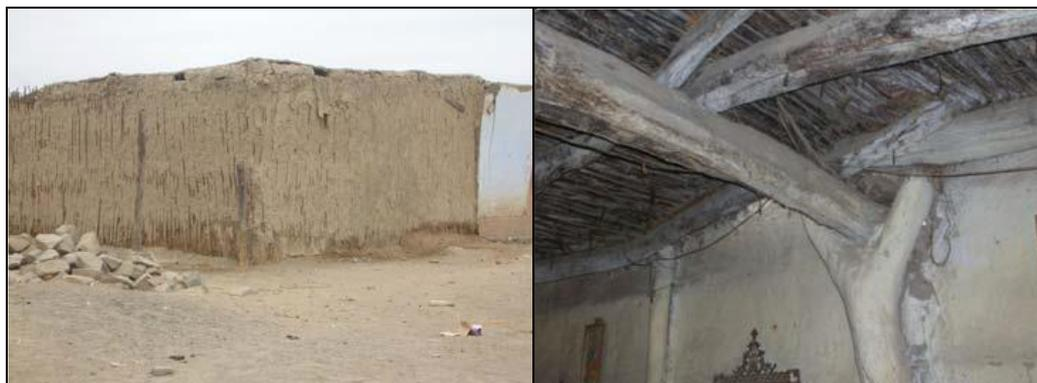
Figura 10 : Muestra de la flexibilidad en construcciones de quincha (a base de madera y caña) posteriores al Terremoto de Pisco 2007
