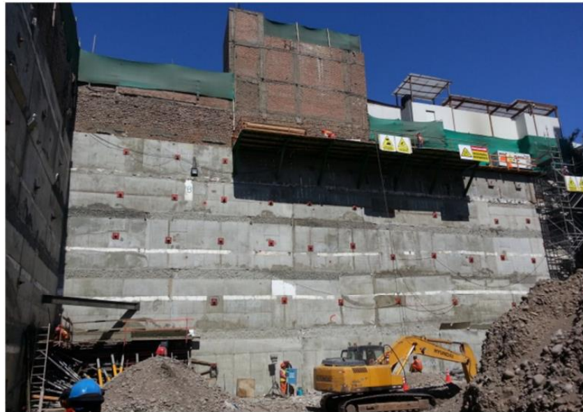
Figura 12. Sistema de muros anclados.
