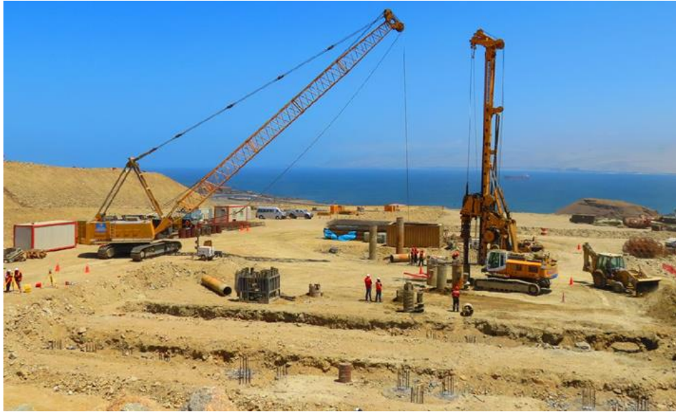
Figura 4: Construcción de cimentaciones profundas (Pilotes)
