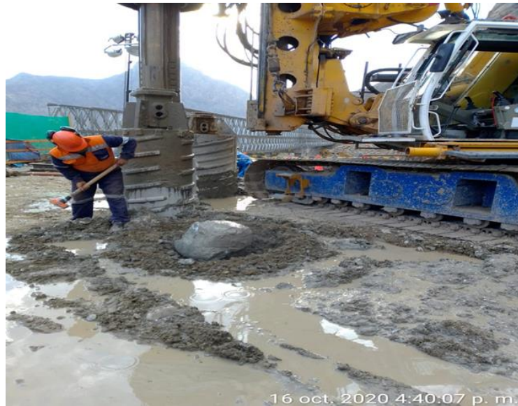
Figura 66. Uso de la herramienta de perforación (Core Barrel) extrayendo boloneras.
