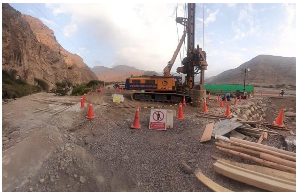
Figura 3: Se observa la perforadora Rotativa Bauer para iniciar con el proceso constructivo de Pilotes Excavados
