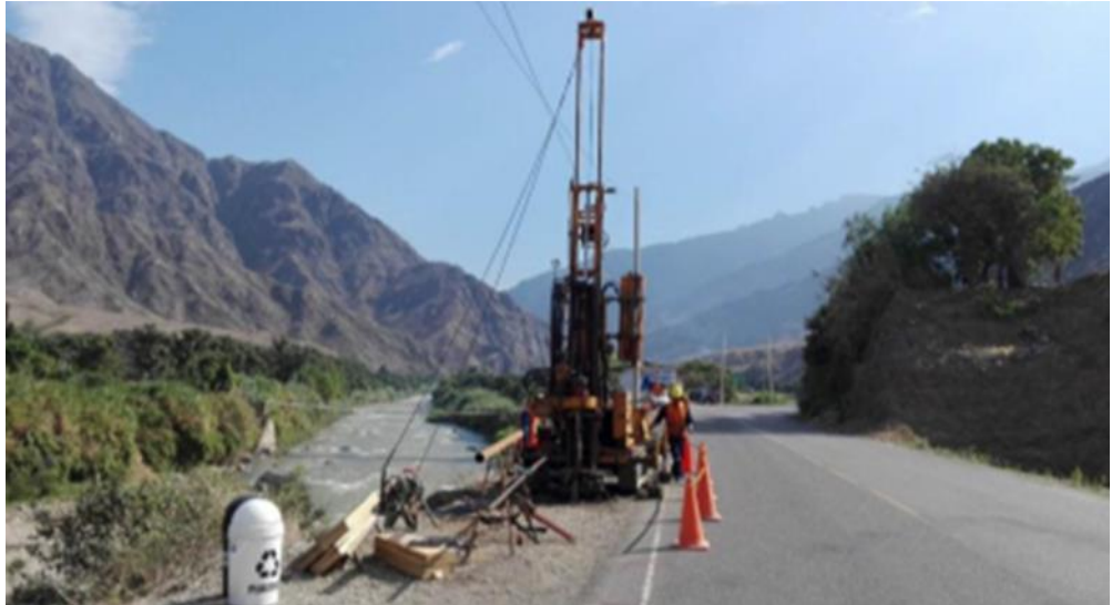
Figura 52. Sondeo P-01 (Estribo Izquierdo) del Puente Pampa Larga
