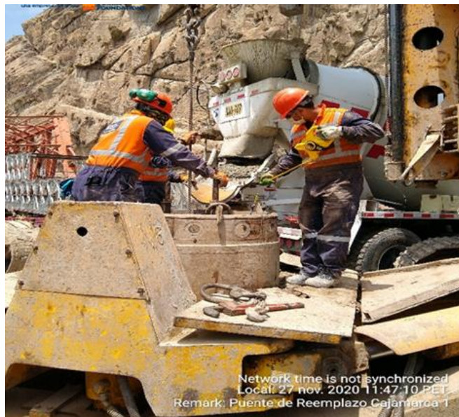
Figura 81. Medición de la posición del hormigón
