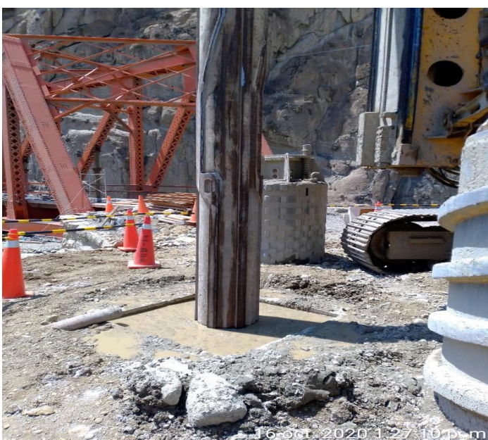
Figura 68. Estabilidad de la perforación con lodo polimérico Fuente: Elaboración Propia de la Obra Puentes por Reemplazo en Cajamarca
