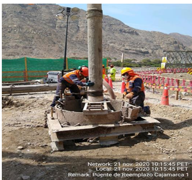
Figura 80. Tubería tremie entre la armadura interior del pilote
