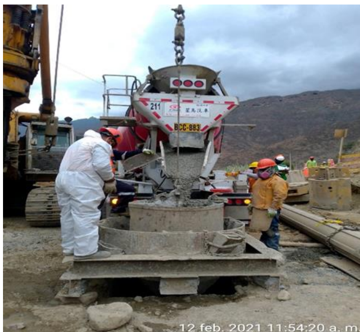
Figura 83. Proceso de hormigonado del pilote
