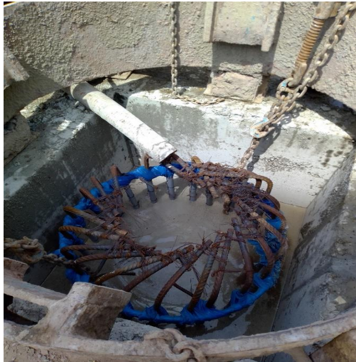
Figura 78. Colocación de armadura dentro del pilote
