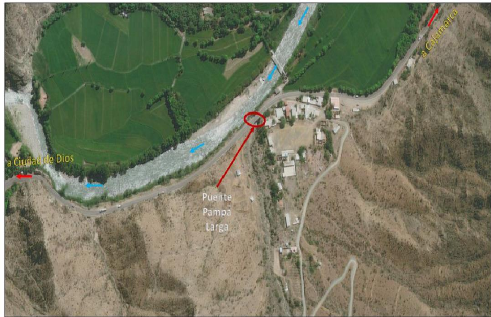
Figura 36. Vista satelital del Puente Pampa Larga
