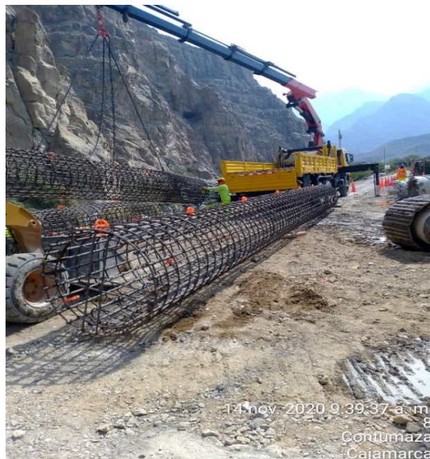
Figura 74. Armadura a pie de Pilote
