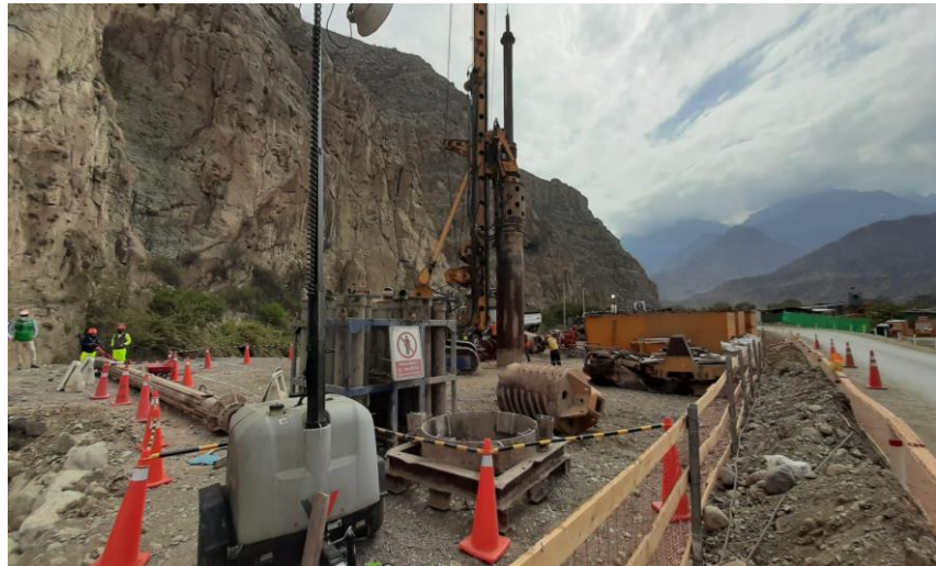
Figura 59. Preparación de la plataforma de trabajo
