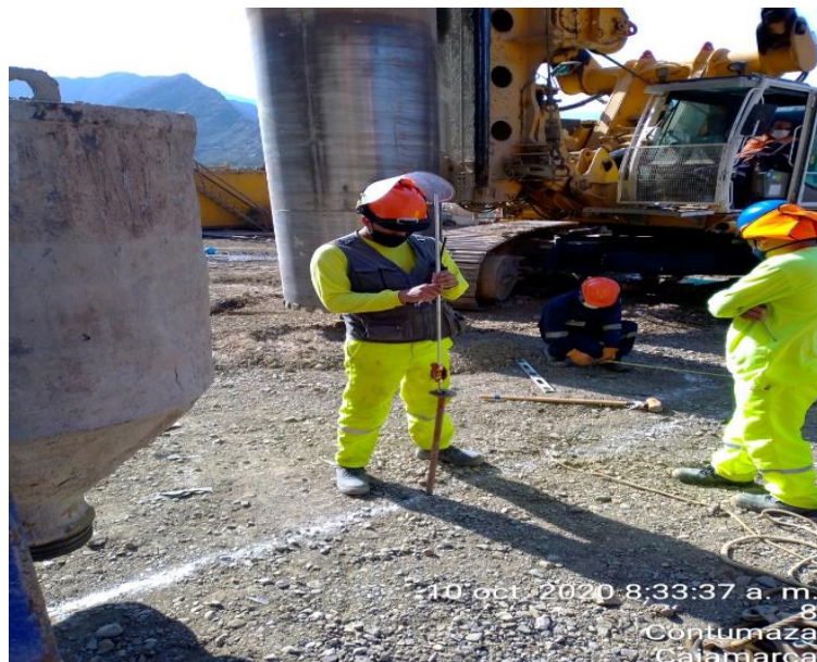
Figura 61. Replanteo del Pilote y murete guía
