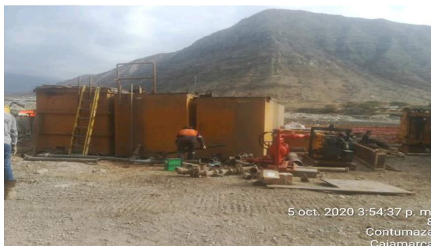
Figura 57. Instalación de la Planta de Lodos
