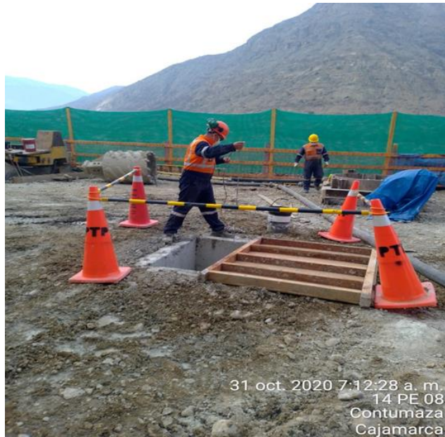
Figura 91. Toma-muestra de lodo de perforación
