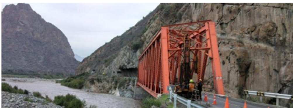
Figura 44. Sondeo P-02 (Estribo Izquierdo) del Puente Yonan
