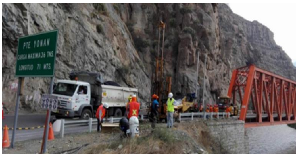
Figura 42. Sondeo P-01 (Estribo Derecho) del Puente Yonan
