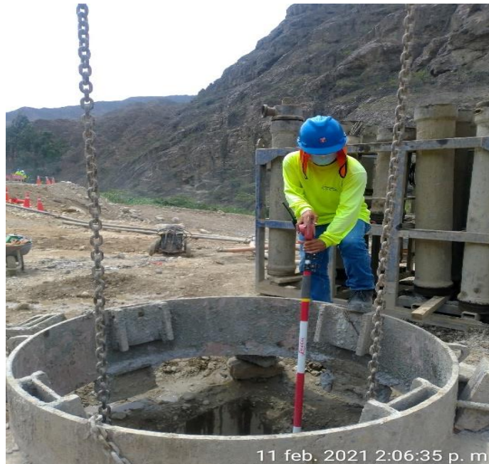
Figura 79. Liberación de cota de armadura
