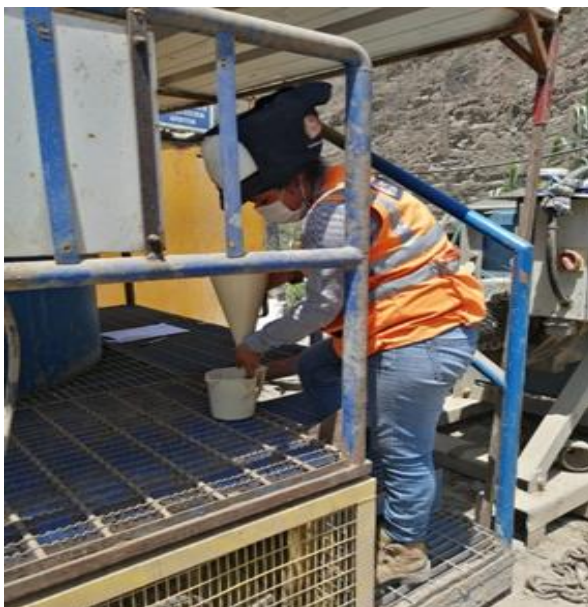
Figura 69. Verificación del lodo de perforación (Lodo polimérico)
