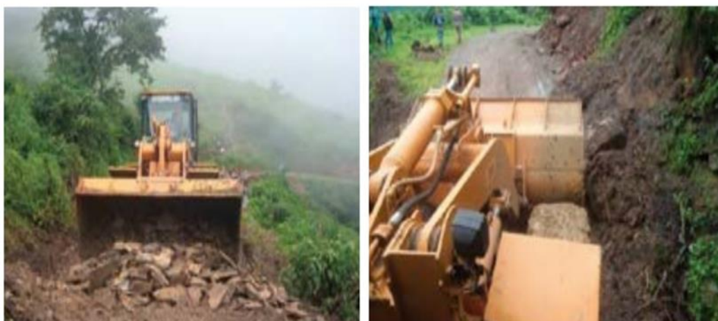
Figura 2: Maquinaria pesada realizando trabajos en carreteras afectadas por Niño Costero
