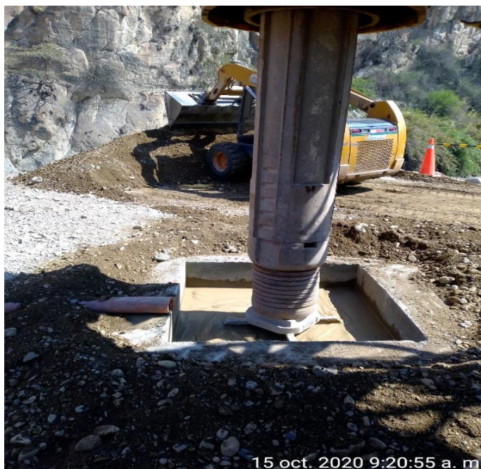
Figura 67. Estabilidad de la perforación con lodo polimérico Fuente: Elaboración Propia de la Obra Puentes por Reemplazo en Cajamarca
