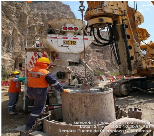
Figura 82. Proceso de hormigonado del pilote
