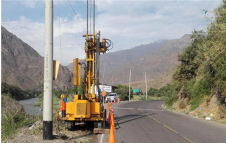
Figura 54. Sondeo P-02 (Estribo Derecho) del Puente Pampa Larga
