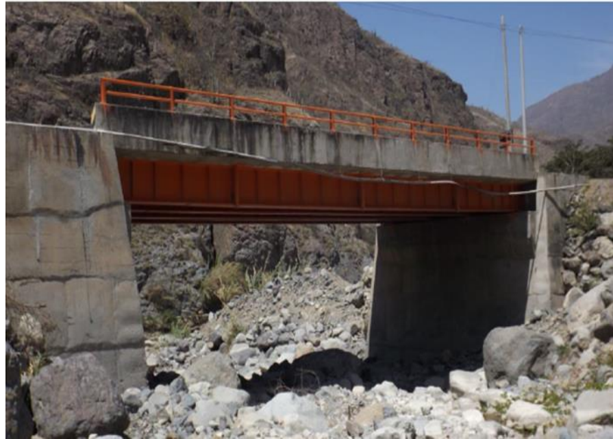
Figura 40. Vista de elevación principal del Puente existente Chuquimango
