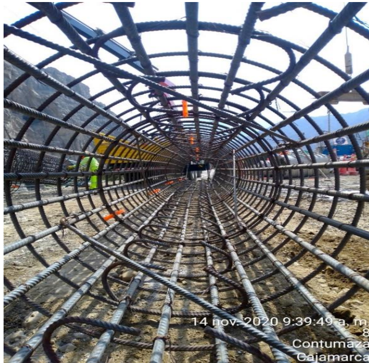
Figura 75. Armadura a pie de Pilote
