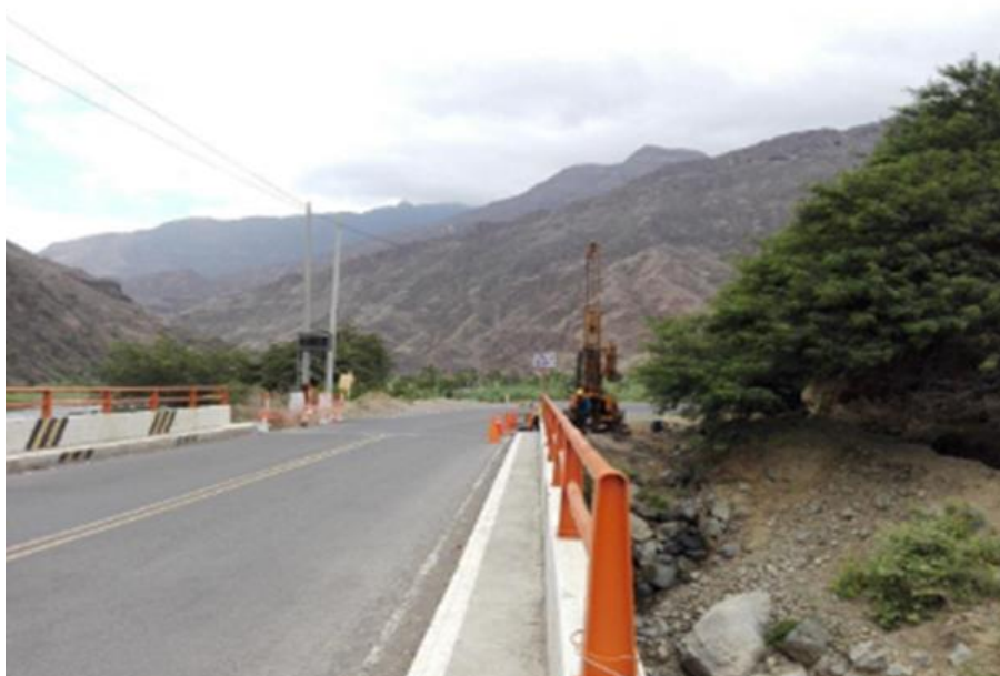
Figura 49. Sondeo P-02 (Estribo Derecho) del Puente Chuquimango Fuente: Expediente Técnico Construcción de puentes por reemplazo en Cajamarca (2019, p.104)
