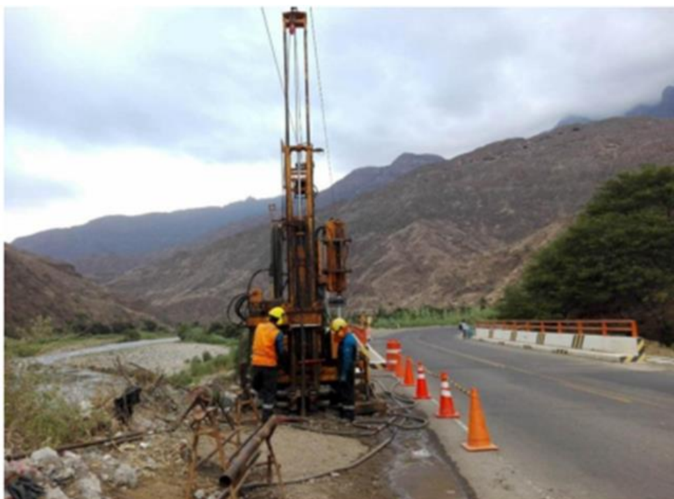
Figura 47. Sondeo P-01 (Estribo Izquierdo) del Puente Chuquimango
