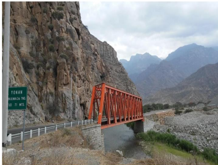
Figura 39. Vista de elevación principal del Puente existente Yonan Fuente: Expediente Técnico Construcción de puentes por reemplazo en Cajamarca (2019).
