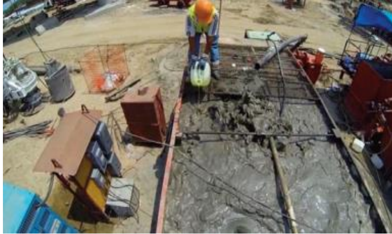
Figura 131: Adición de hipoclorito de sodio al fluido
