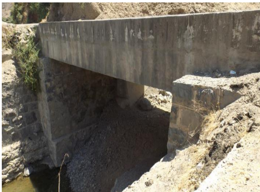
Figura 41. Vista de elevación principal del Puente existente Pampa Larga
