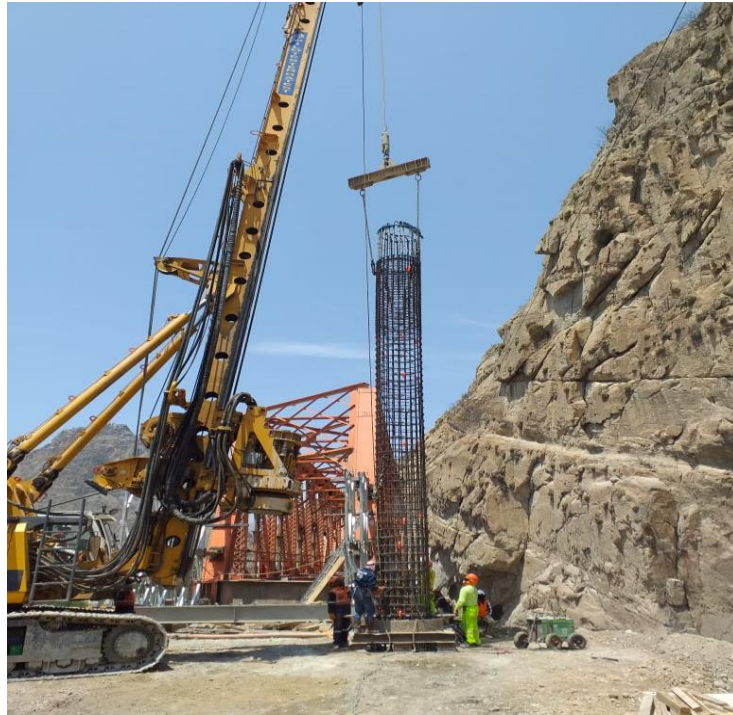
Figura 77. Procedimiento de izaje de armadura con balancín
