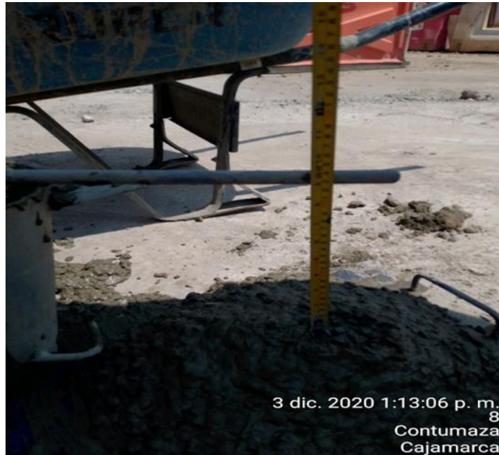
Figura 84. Control de calidad del hormigón (Asentamiento en Cono Abrams)
