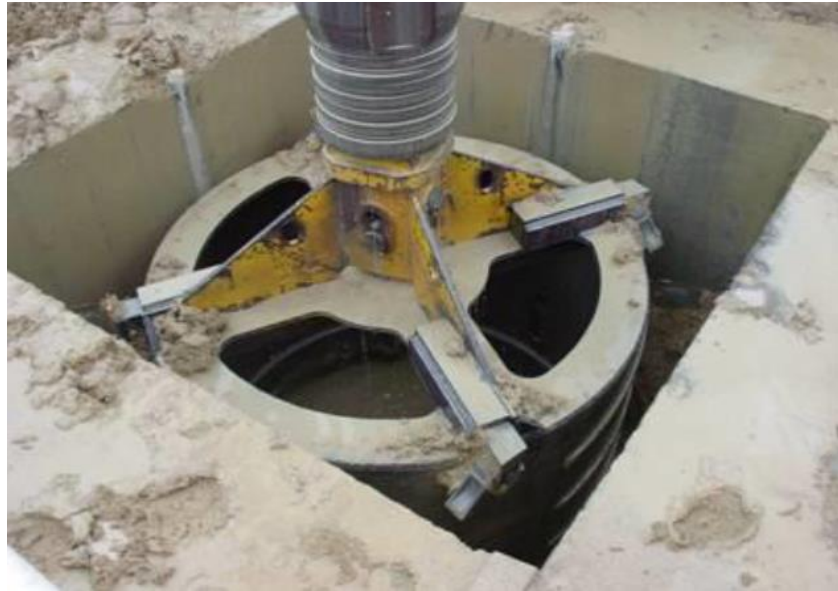
Figura 62. Murete guía e inicio de la perforación
