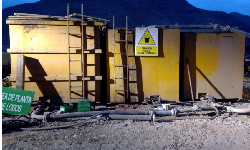
Figura 58. Instalación de la Planta de Lodos
