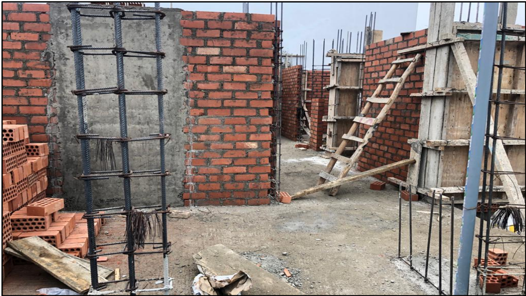
Figura N° 59: Albañilería para la división de ambientes en platea de cimentación
