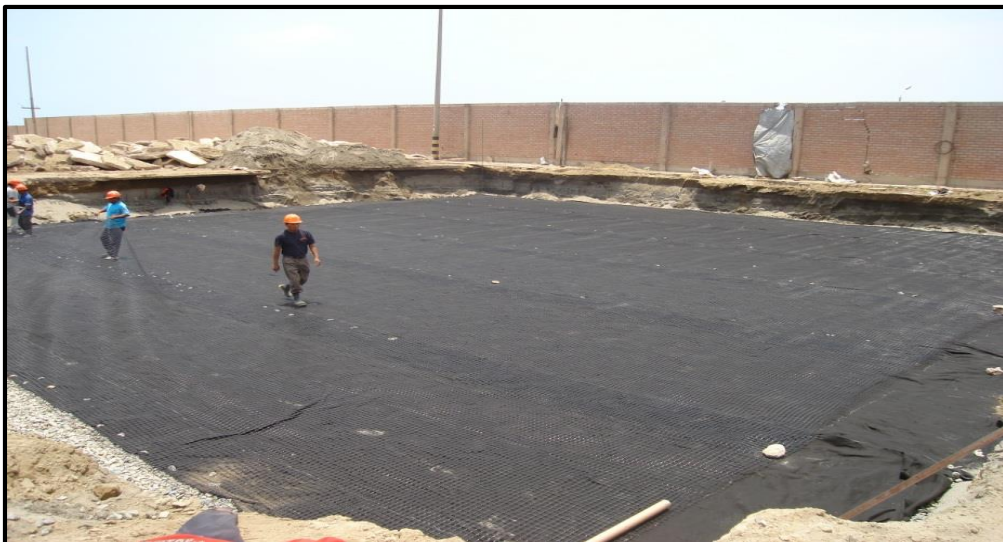
Figura N° 33: Instalación de Geotextil y geomalla terminada
