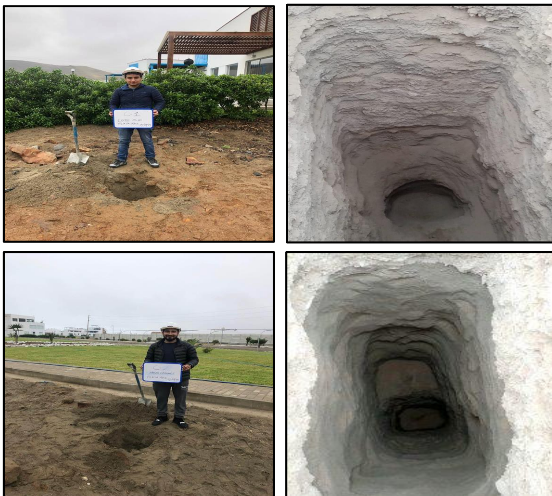
Figura N° 35: Toma de muestras y realización de calicatas en el Condominio Playa Azul
