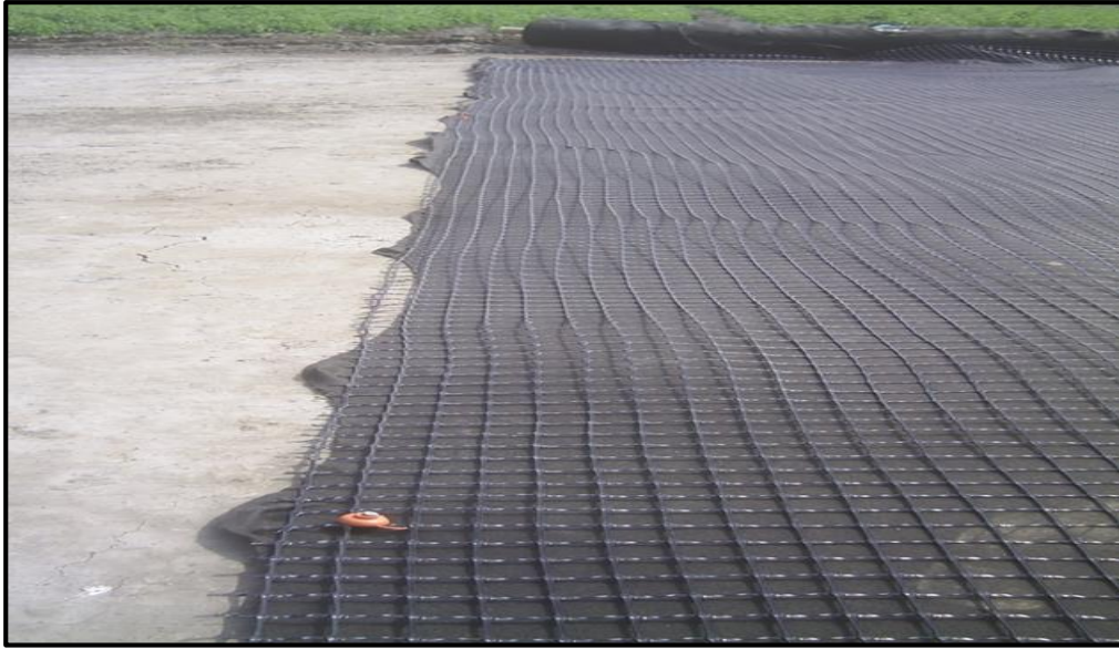
Figura N° 32: Fijación de geomallas mediante estacas
