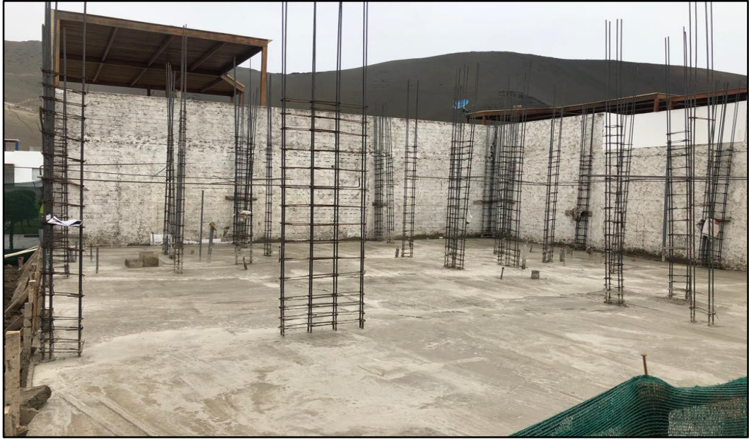
Figura N° 58: Platea de cimentación culminada en el Condominio Playa Azul
