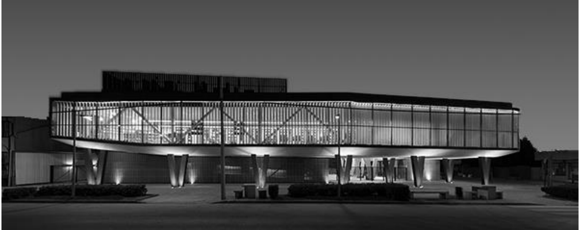
Figura N°2: Centro Cultural Arauco
