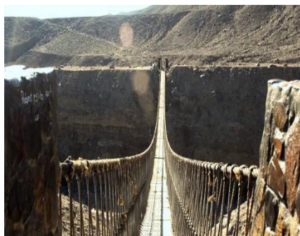
Figura N°18 Puente colgante de Miculla
