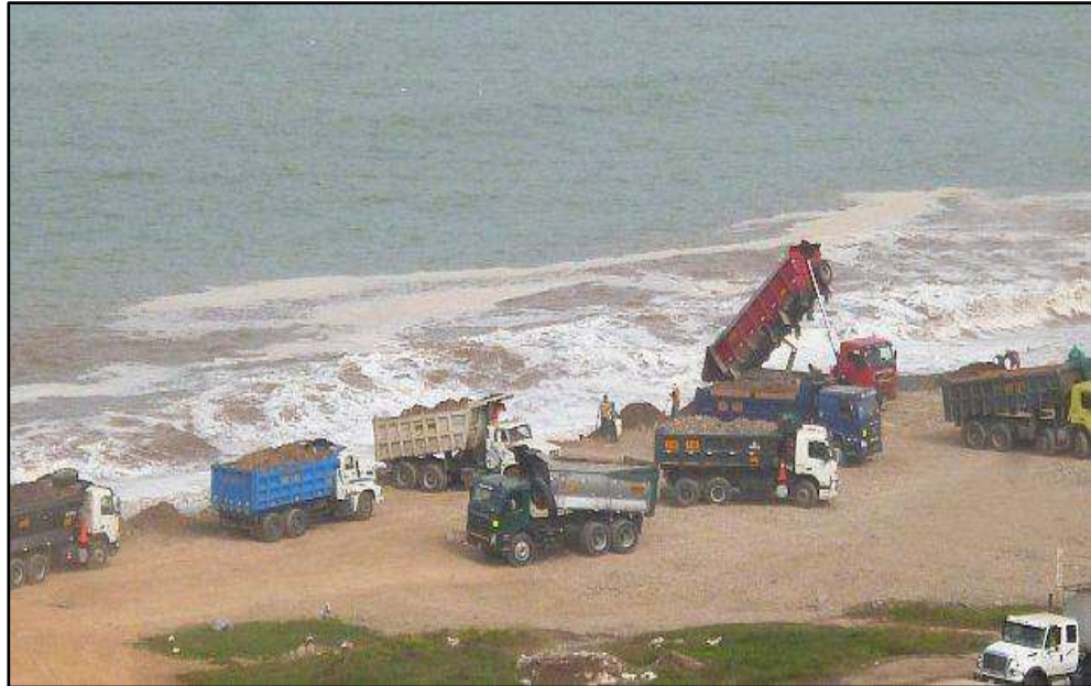
Foto N° 1: Material de excavación arrojado a la Costa.
