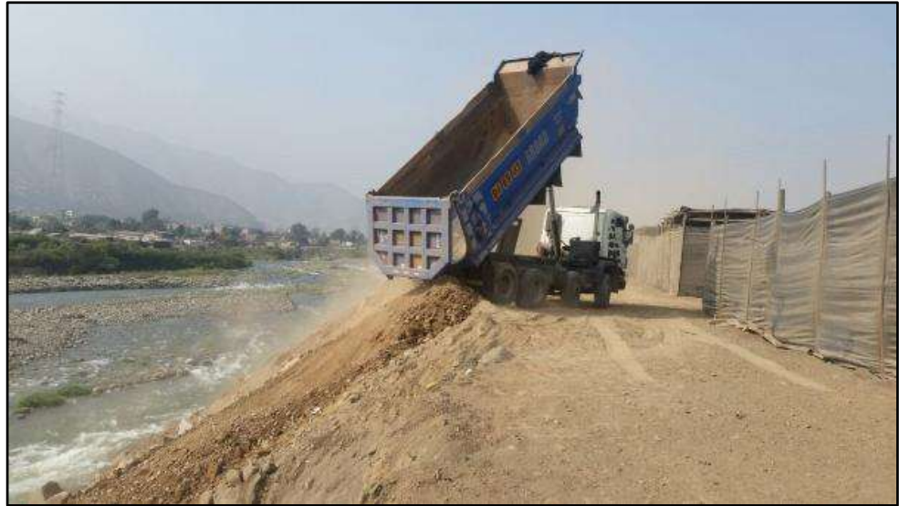
Foto N° 2: Volquete descargando desmote en ladera del río Rímac
