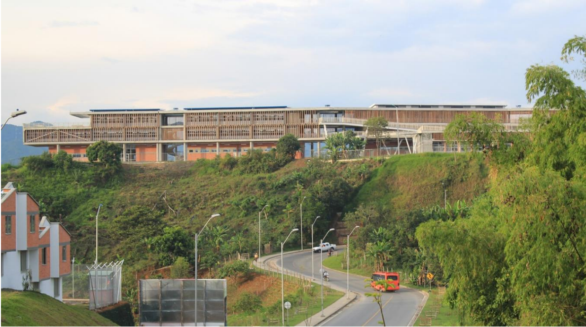
Imagen 37: Fotografía del exterior de la institución educativa "La Samaria" Recuperado en julio del 2019 Fuente: https://www.archdaily.pe
