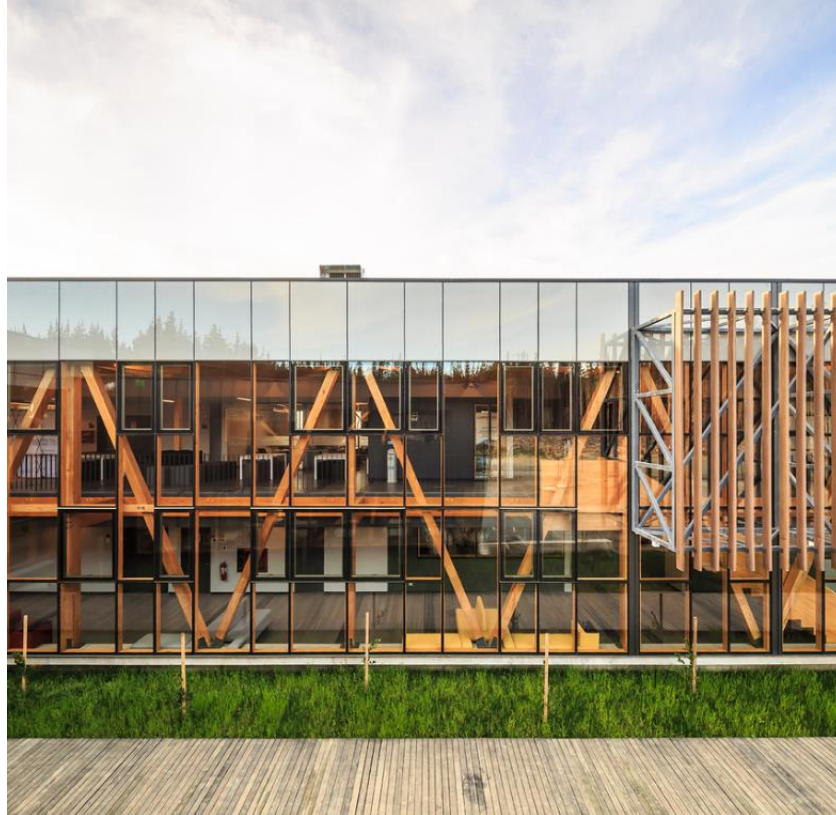
IMAGEN 18: FACHADA CENTRO DE FORMACION TECNICA "ARAUCO" Fuente: https://www.archdaily.pe/pe/885963/cft-arauco-duocuc-gdn-
