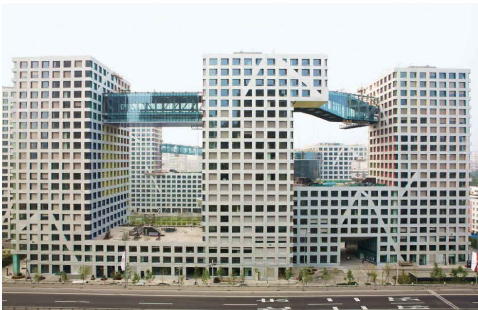
Foto 1: Vista fotográfica del edificio Linked Hybrid-Steven Holl Architects
