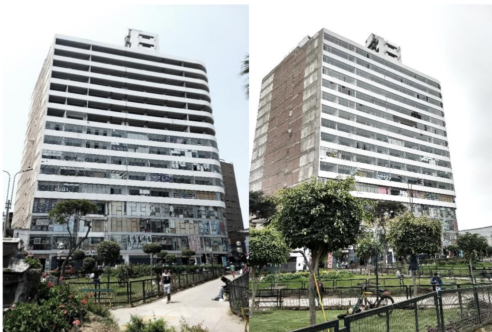
Foto 17: Vistas fotográficas de la galería comercial San Pedro desde el parque Divino Maestro-damero A de Gamarra.
