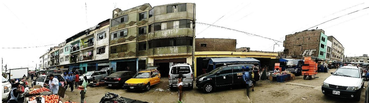
Foto 25: Vista fotográfica 3: Cara este de los lotes pertenecientes a la manzana donde corresponderá la ubicación de la futura plaza pública con conexión hacia la estación de la Línea 2 del Metro de Lima (tren subterráneo) y la del proyecto arquitectónico en el distrito de La Victoria.
