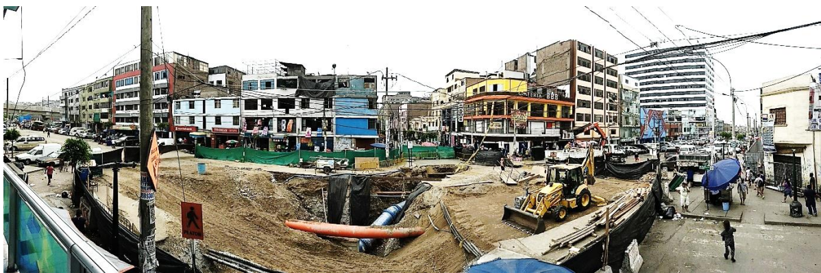
Foto 11: Vista fotográfica del cruce del jr. Gamarra con la av. Bausate y Meza. Actualmente existe una excavación que bifurca el flujo peatonal por sus contornos.
