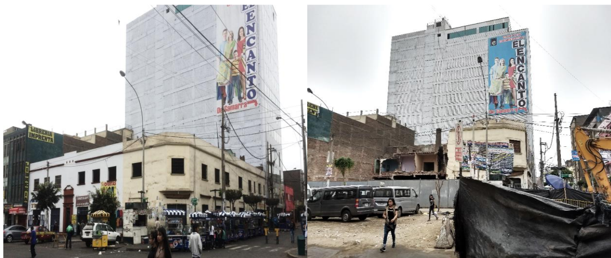
Foto 14: Vista fotográfica en la intersección del jirón Gamarra y la avenida Bausate y Meza en el conglomerado comercial Gamarra. (Izq.) Vista fotográfica del cruce de avenida Bausate y Meza y el jirón Gamarra. Actualmente se está llevando a cabo la demolición de un lote de dos niveles para la construcción de un nuevo centro comercial. (Der.)
