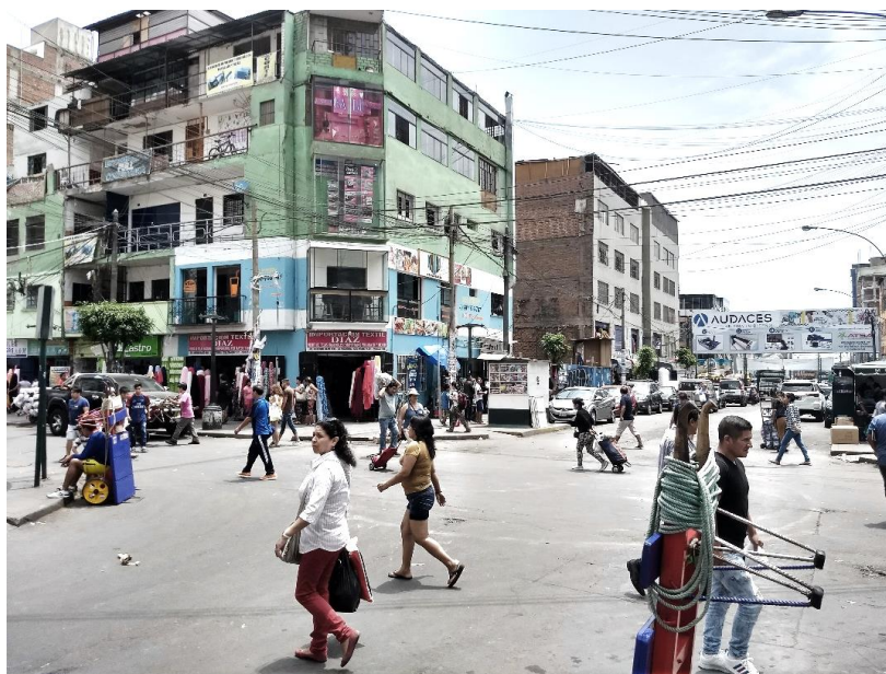
Foto 13: Vista fotográfica del cruce de los jirones Antonio Bazo y San Cristóbal. Actualmente no posee una alta presencia de comerciantes ambulantes.
