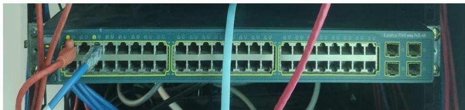
Figura 26: Switch colocado en el rack e integración de los dos primeros puertos.
