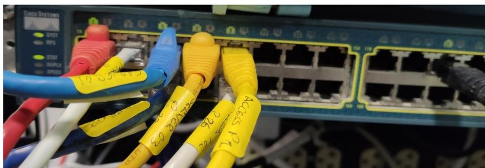
Figura 29: Conexión de los servidores y los AP.
