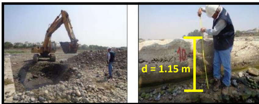
Figura 12.- Vista de las excavaciones exploratorias de la pantalla 10
