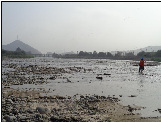
Figura 5.- Imagen aguas debajo de la cuenca del río Rímac. En el fondo se observan las bocatomas 1 y 2; y las pantallas de infiltración Fuente: Trinity Group
