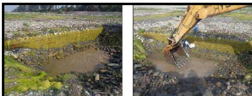
Figura 14.- Vista de las excavaciones exploratorias de la pantalla 20
