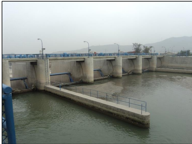
Figura 4.- Vista de las bocatomas 1 y 2 de la planta de tratamiento La Atarjea. Fuente: Trinity Group
