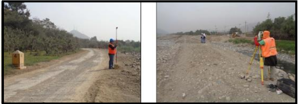
Figura 28.- Imagen del levantamiento topográfico de las pantallas de infiltración.
