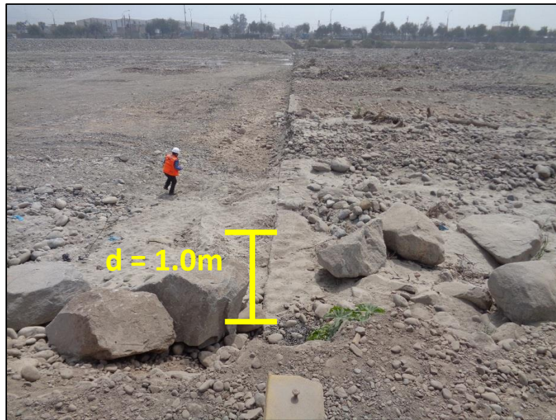
Figura 7.- Imagen de pantalla con presencia de asentamientos e inclinaciones
