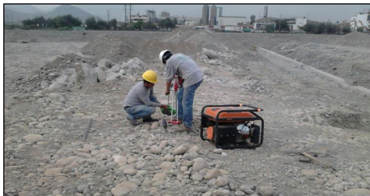
Figura 38.- imagen de personal de laboratorio extrayendo muestras de concreto. Nótese la pantalla enterrada en la zona derecha.
