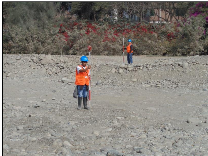
Figura 29.- Imagen del levantamiento topográfico de las pantallas de infiltración.
