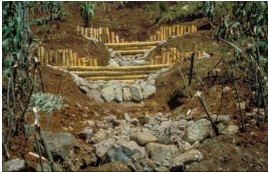
Figura N° 62: Estructuras de estabilización de quebradas.
