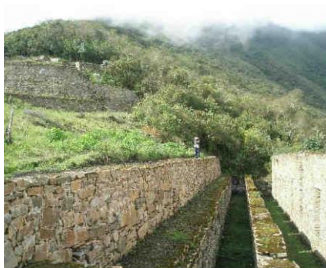
Figura N° 5: Muro de contención en andenes incas en Sector Alto de Choquequirao.
