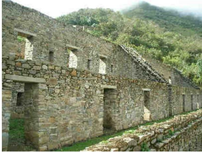
Figura N° 6: Qolqas protegidos por andenes construidas sobre muros de contención.
