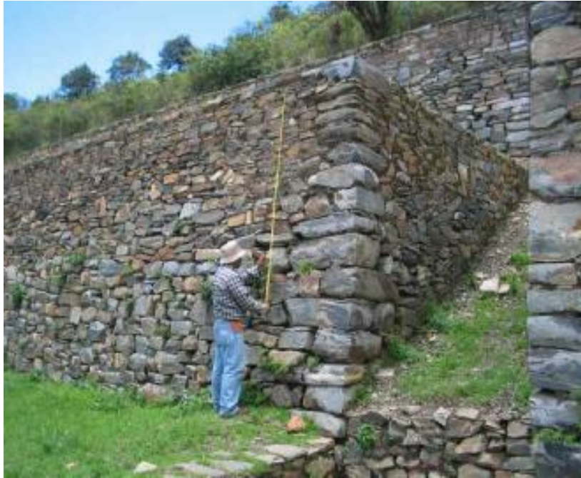
Figura N° 8: Andenes del Chaqraanden con drenaje de grandes dimensiones.
