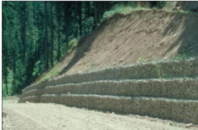
Figura N° 83: Estructuras de gaviones de baja altura.
