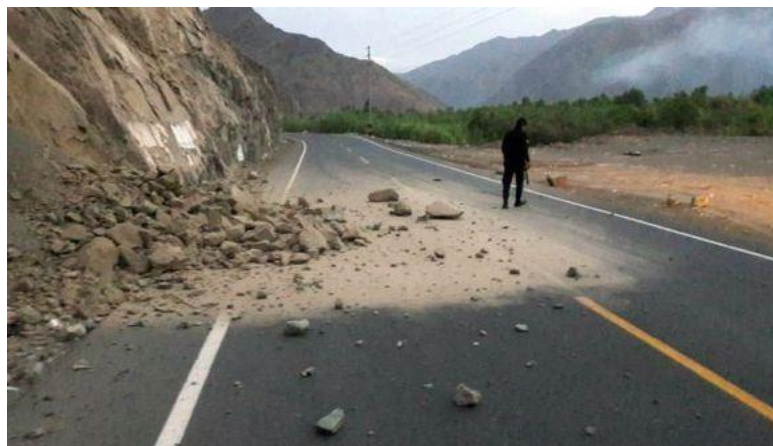
Figura N° 16: Deslizamiento en carretera de bajo volumen en Huarney.
