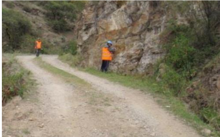
Figura N° 124: Rehabilitación de muro de piedra en la progresiva 02+210.
