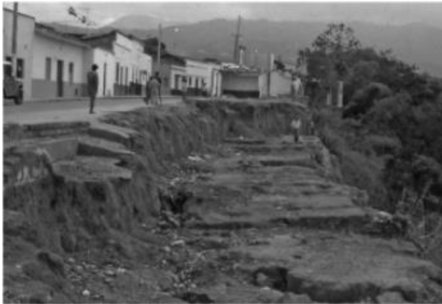
Figura N° 27: Movimiento de Rotación.
