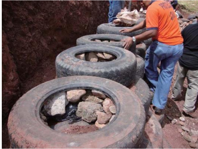
Figura N° 91: Colocación de rocas dentro de las llantas.
