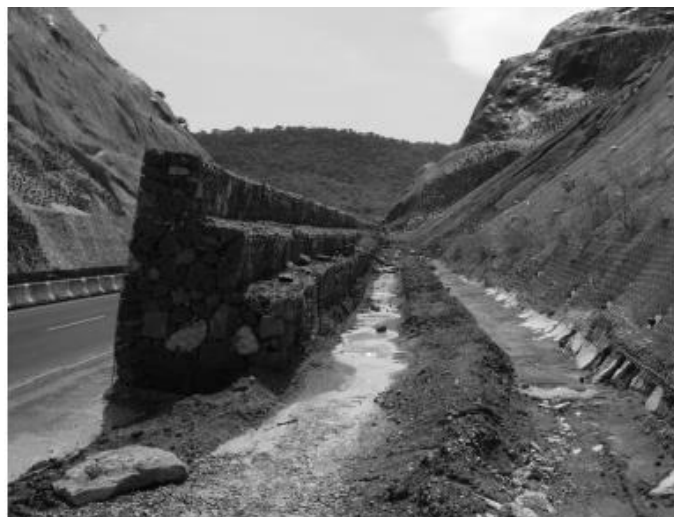
Figura N° 54: Muro "Alcancía" para protección contra caídos.
