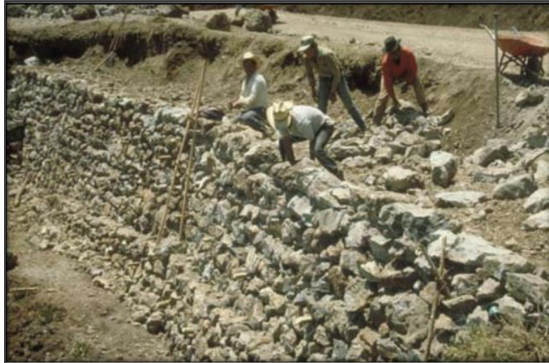
Figura N° 82: Métodos de estabilización en taludes.
