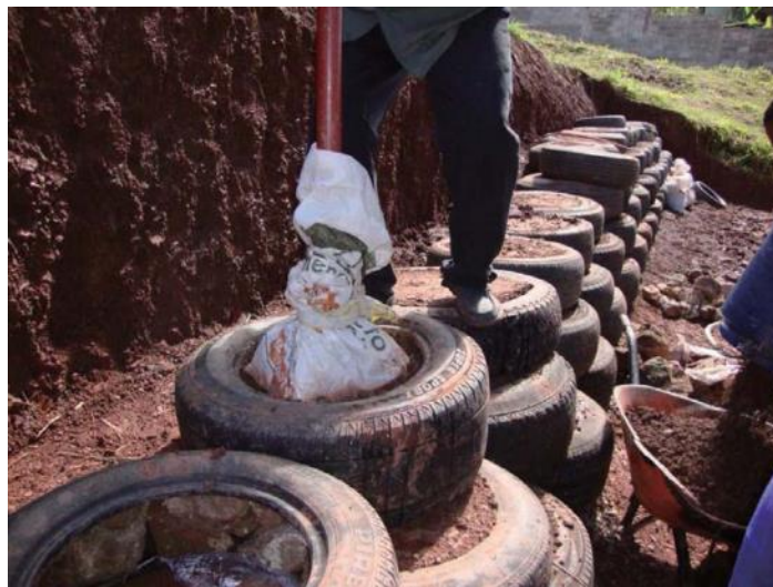
Figura N° 92: Compactación manual de rocas del suelo-cemento.
