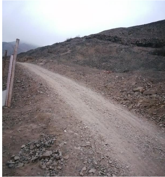
Figura N° 49: Talud en carretera vecinal.
