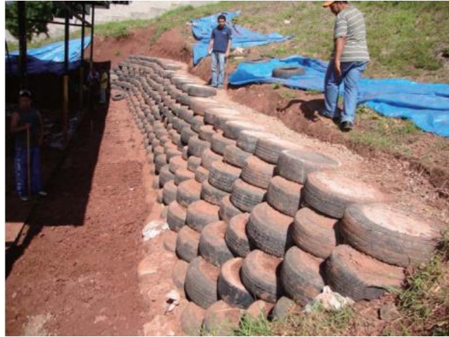
Figura N° 93: Talud estabilizado con muro de llantas.
