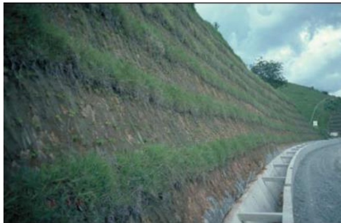
Figura N° 65: Hileras de pasto para estabilización y control de erosión.
