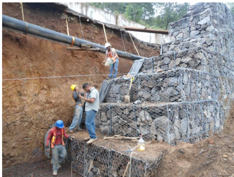
Figura N° 86: Proceso constructivo de muro de gaviones.
