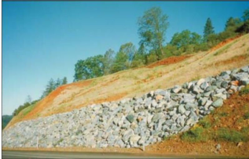
Figura N° 76: Contrapeso de contrafuerte de roca permeable.
