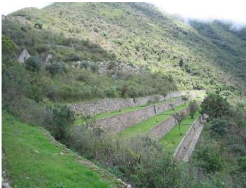
Figura N° 7: Conjunto de andenes que estabiliza el deslizamiento en Choquequirao.
