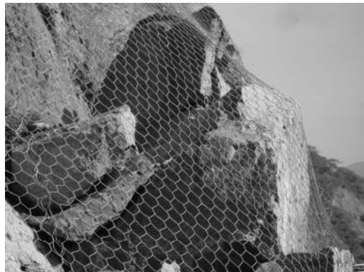
Figura N° 52: Control de rocas con mallas ancladas.
