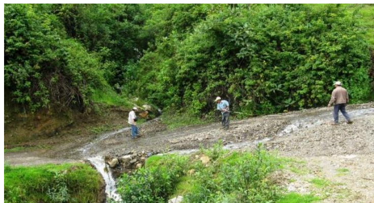
Figura N° 134: Zona crítica progresiva 1+039.
