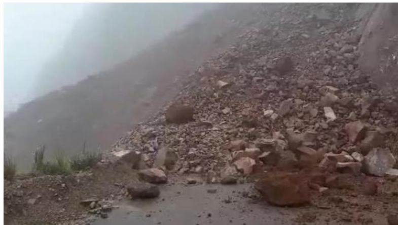
Figura N° 95: Caída de rocas en la vía Cusco-Paucartambo.
