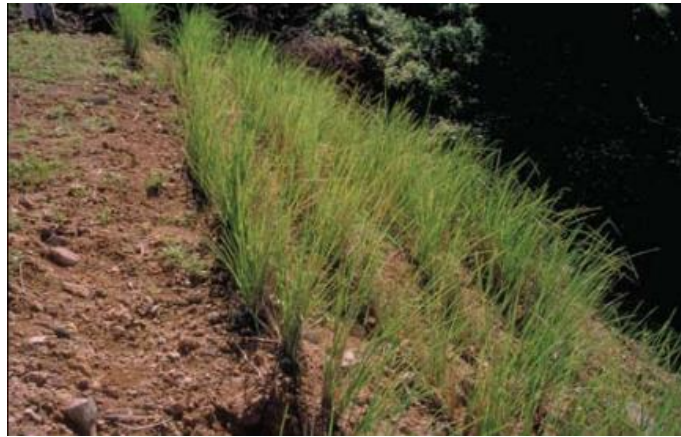
Figura N° 64: Uso de pasto Vetiver para estabilizar el talud y control de erosión.
