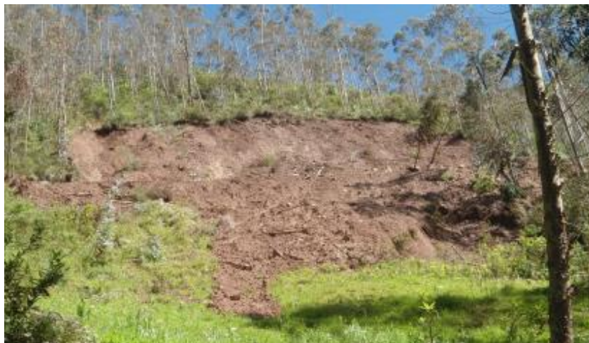
Figura N° 115: Sector crítico km 23+860.
